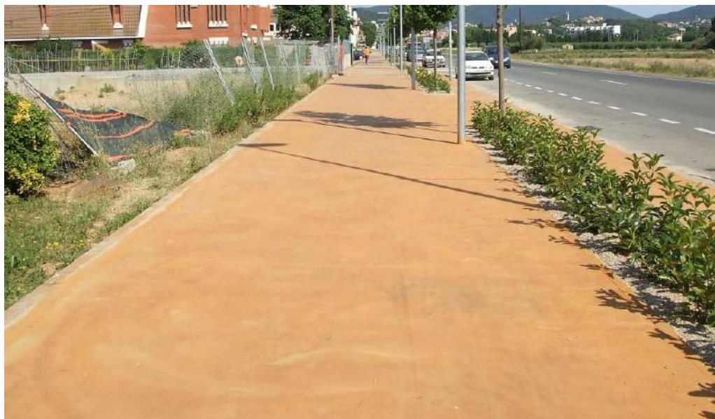
Exemple de vorera resolta amb un paviment de formigó remolinat i posteriorment pintat amb sulfat de ferro.
