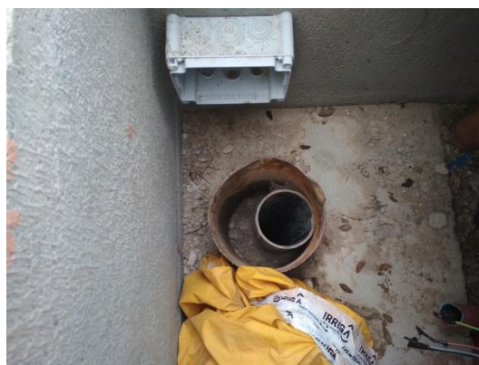
Detall de l'interior de l'arqueta. Es pot veure la canonada exterior metàl·lica, i la canonada de PVC de revestiment. La canonada metàl·lica, per l'embrocament superior, té uns 2 m. La de revestiment arriba al fons del pou, uns 84 m.
