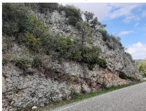
Imatge de la carretera TV-2012 on es mostren les calcàries i dolomies grises basculades cap al NO, que formen la unitat PEEc, les quals són explotades a la pedrera de Vilaperdius. Es poden observar discontinuïtats, fissures verticals i paleokarsts.
