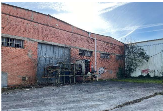
Façana oest de la nau i porxo d'entrada
