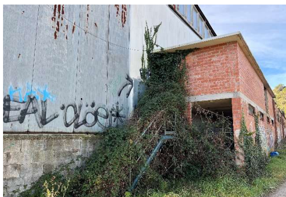
Façana nord de la nau i cos annex
