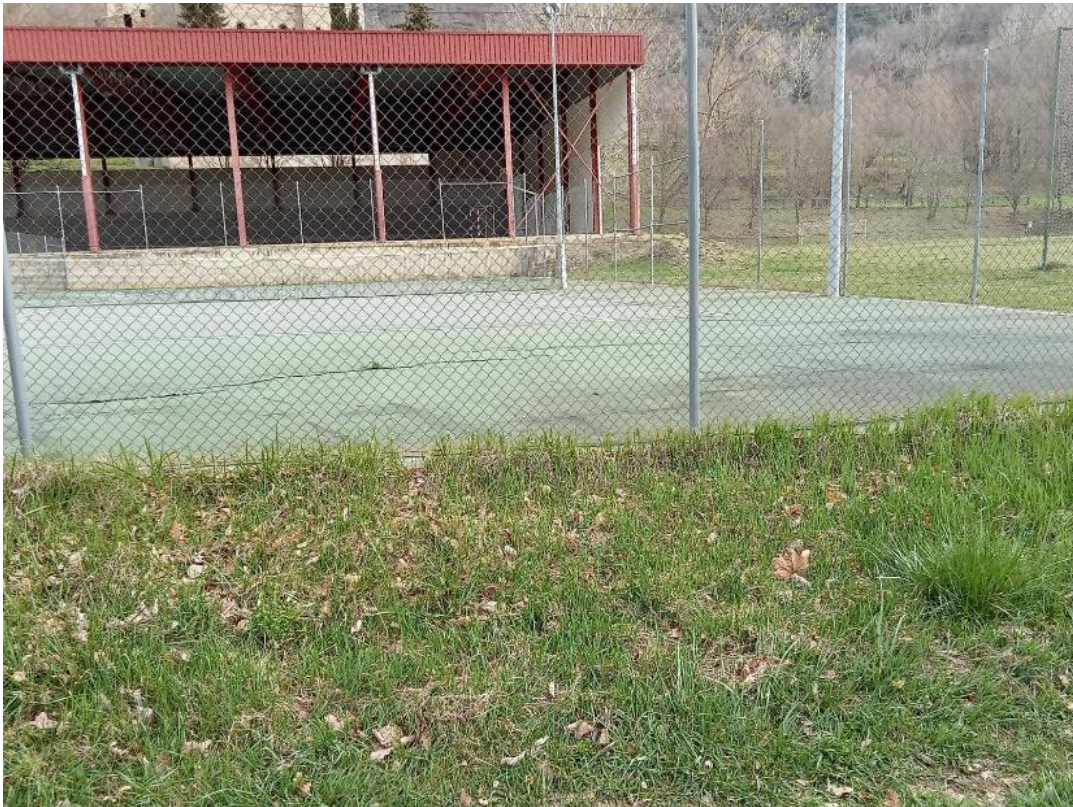
Zona en que el terra ha cedit del camp de futbol.
