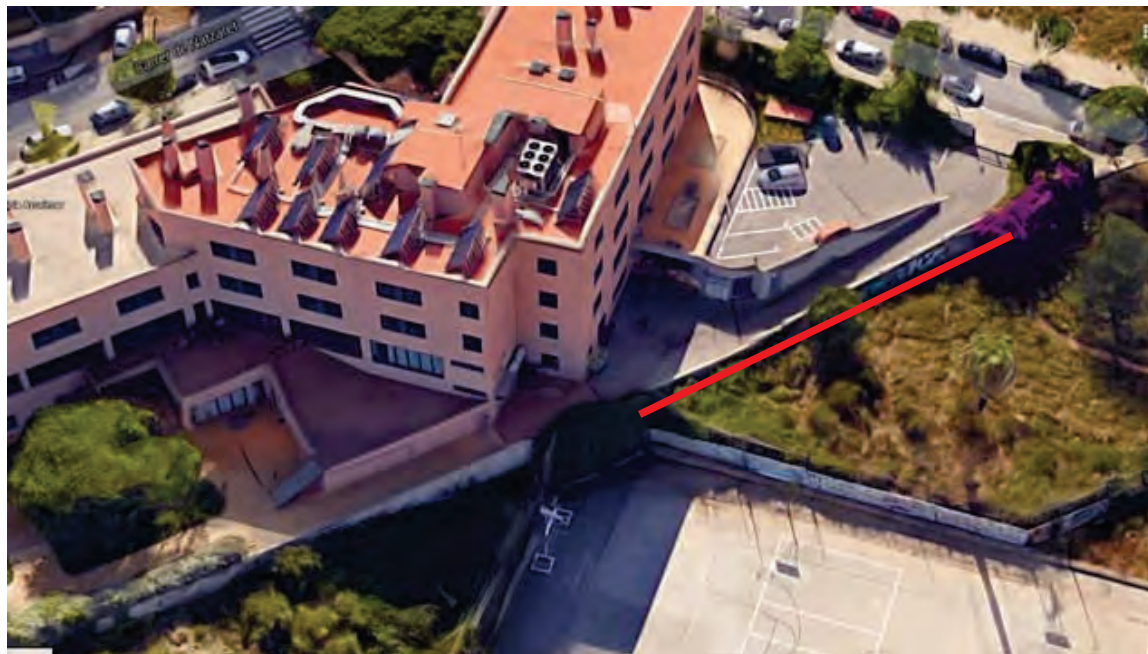
Situación pantalla de pilotes
