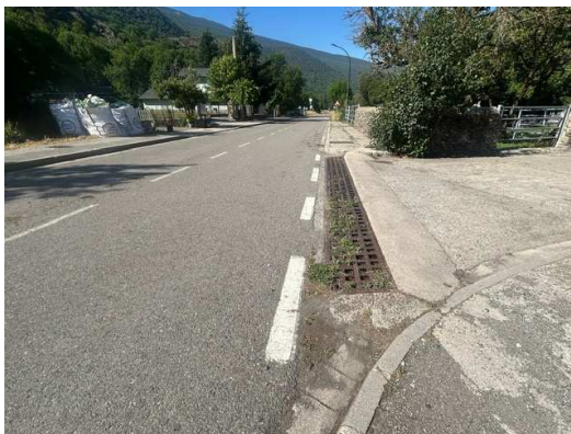
Imatge 01. Estat actual de la vorera i la reixa existent
