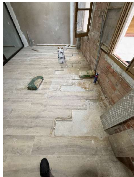
Falta acabar paviment, tirar paret de tancament i finestres, arrebossar i pintar parets i col·locació de barana.
