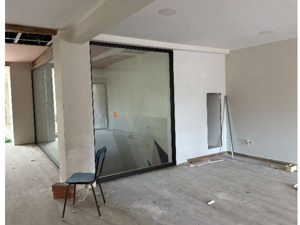
Fet el forat del rocòdrom i col·locats els tancaments fixes. Falta porteta lateral. Així com a l'escala de baixada al rocòdrom, que també cal el tancament.
