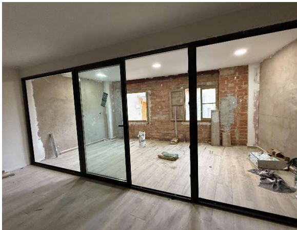
Col·locat el tancament del porxo.
