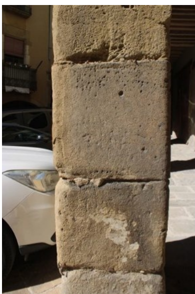
Dos exemples de les alteracions superficials: enfosquiment per acumulació de brutícia a les pilastres i tinció de les bases dels balcons per òxid procedent de les baranes.
