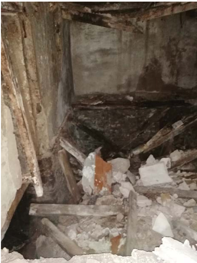
FOTO 8.8 - Enderrocàmbit D posterior
