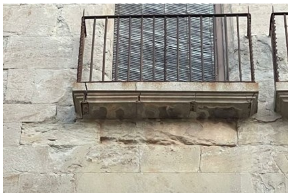
Detalls del mal estat que presenten tant les bases balconeres de formigó com els carreus situats sota d'elles.
