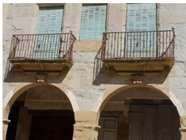
Detalls de la combinació de materials petris a la façana. Les característiques poc estables del gres emprat en la construcció de les pilastres obliguen a emprar una pedra de millors prestacions per al basament inferior.
