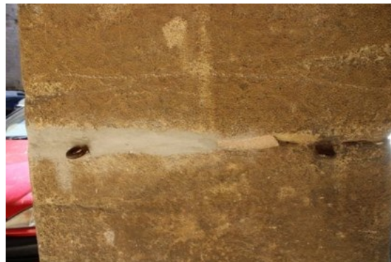
Morters de reparació inadequats a les pilastres del pòrtic.
