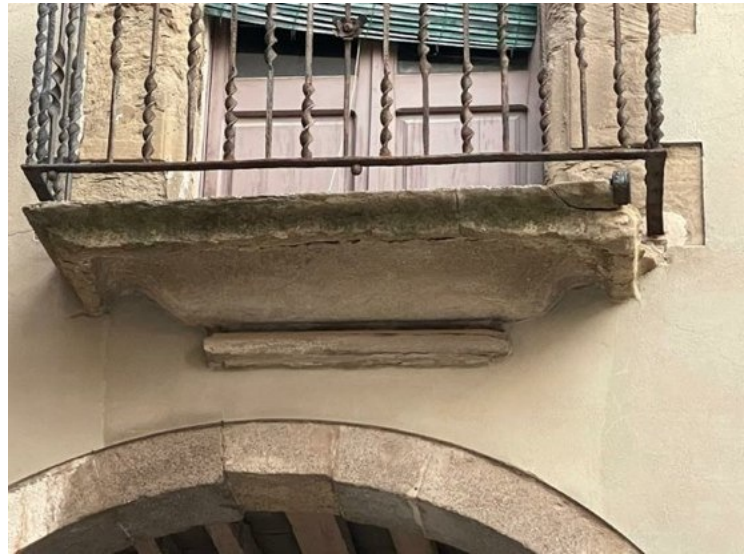
Les bases dels balcons, esculpides amb el mateix gres de de tonalitat marró, també presenten les mateixes patologies, sent uns dels elements arquitectònics més alterats.
