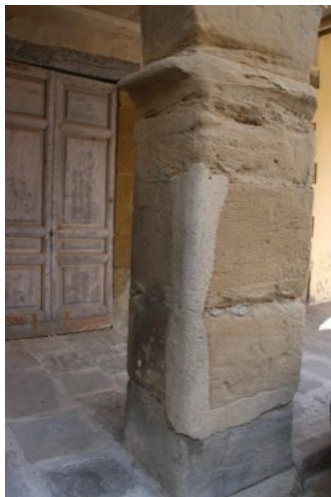
Morters de reparació inadequats a les pilastres del pòrtic.
