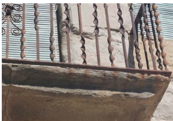
Dos exemples de les alteracions superficials: enfosquiment per acumulació de brutícia a les pilastres i tinció de les bases dels balcons per òxid procedent de les baranes.
