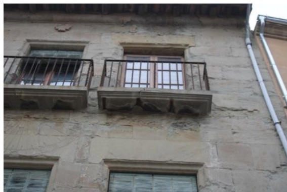
Detalls del mal estat que presenten tant les bases balconeres de formigó com els carreus situats sota d'elles.
