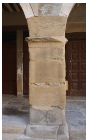
Detalls de la combinació de materials petris a la façana. Les característiques poc estables del gres emprat en la construcció de les pilastres obliguen a emprar una pedra de millors prestacions per al basament inferior.
