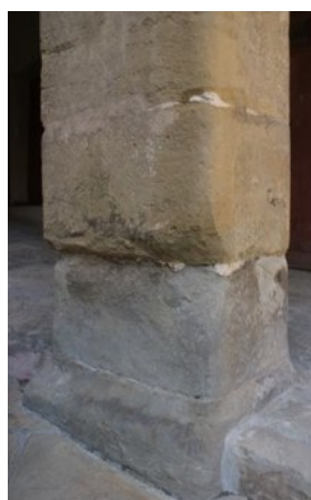
Detalls de la combinació de materials petris a la façana. Les característiques poc estables del gres emprat en la construcció de les pilastres obliguen a emprar una pedra de millors prestacions per al basament inferior.
