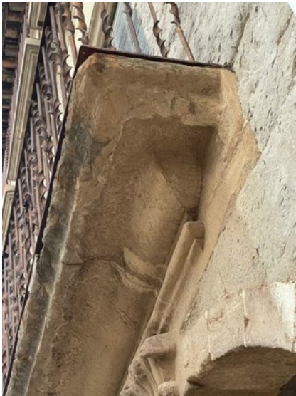
Les bases dels balcons, esculpides amb el mateix gres de de tonalitat marró, també presenten les mateixes patologies, sent uns dels elements arquitectònics més alterats.
