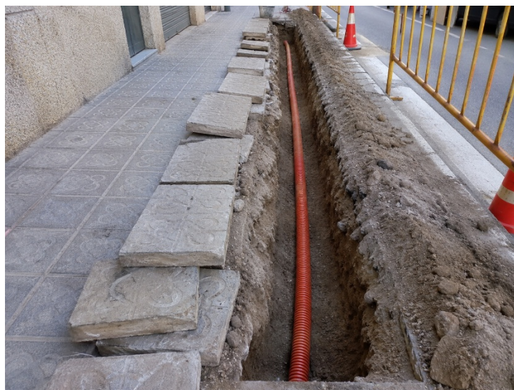
Rasa d'escomesa amb tub corrugat de 63 mm.
