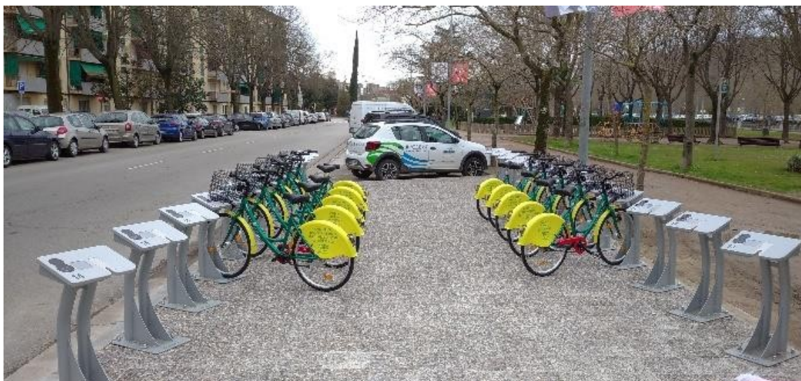
Exemple 6: Vista estació executada, amb els peus d'aparcament muntats per TMG a sobre les platines. Si les platines no estan ben anivellades l'ancoratge de les bicicletes al peu d'aparcament dona problemes i caldrà arreglar-ho per compte de l'adjudicatària.
