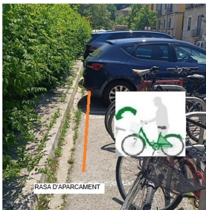
Imatge 38_05: Detall punt inici per l'oest de rasa d'aparcament respectant la rigola. Sentit aparcament. Font: elaboració pròpia.
