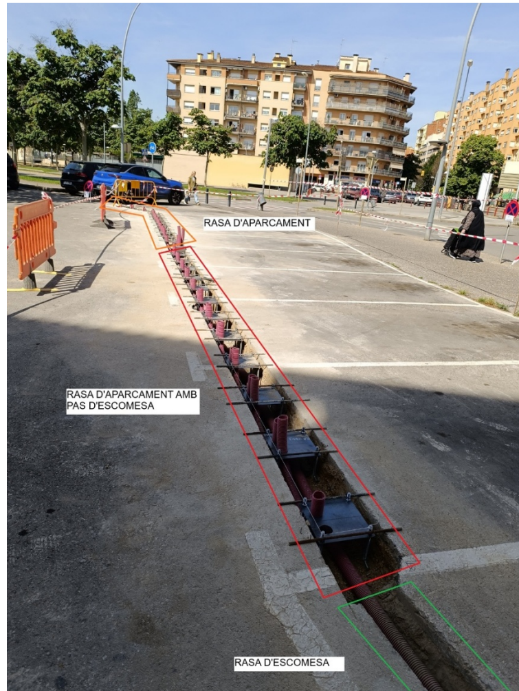
Exemple de tipus de rases d'una estació de Girocleta amb detall de les platines anivellades i diferents amplades de les rases
