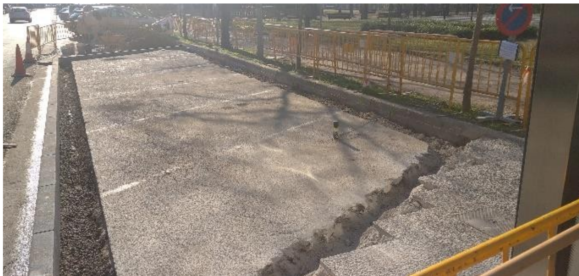
Exemple 2: Execució de la rasa d'aparcament
