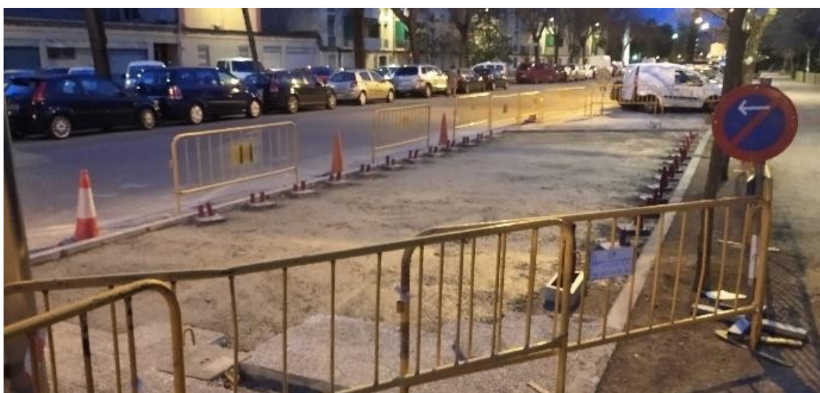
Exemple 5: Vista de platines anivellades i perfectament ancorades en estació pendent de reposar el paviment
