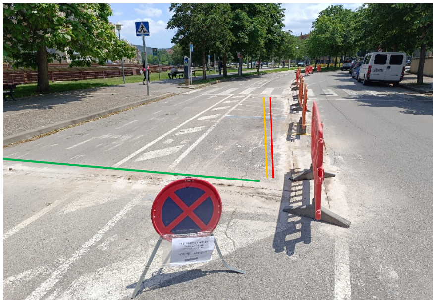
Exemple 1: Vista paviment tallat per a rasa d'aparcament o de rasa d'aparcament amb pas d'escomesa i rasa d'escomesa a observar les diferents amplades d'ambdues rases .
