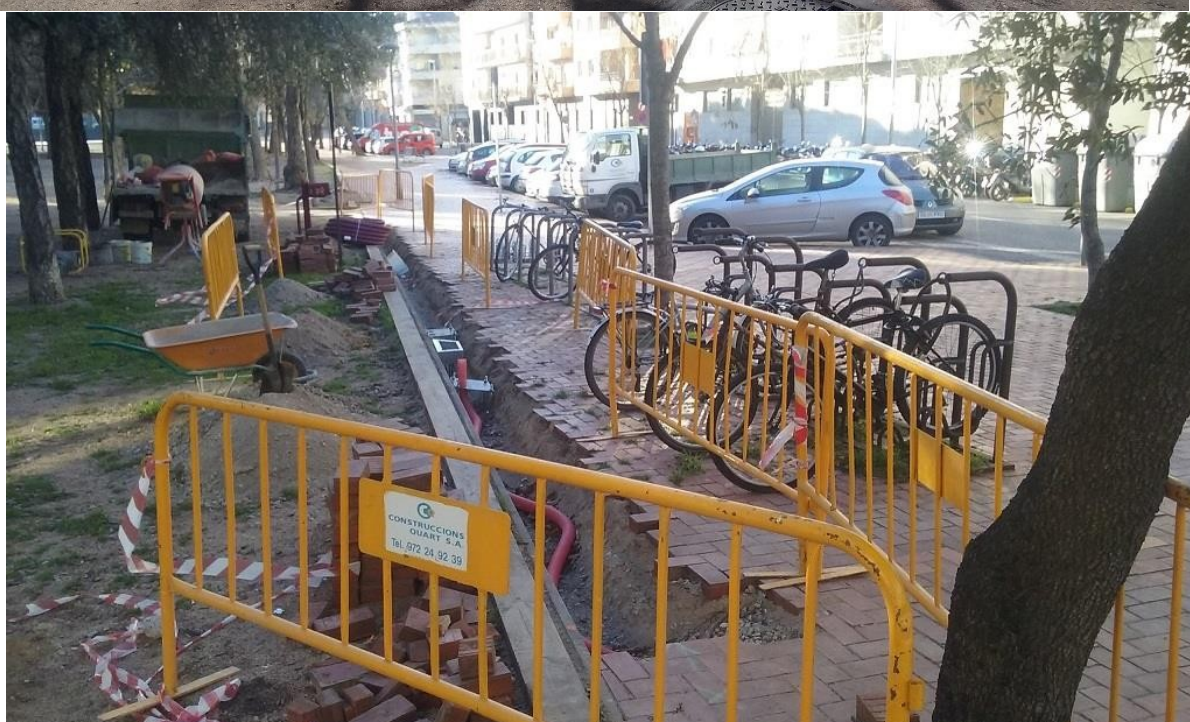
Exemple 10: Imatge general de l'obra civil d'una estació en plena execució. Particularitats: cal adaptació de l'obra a la ubicació de cada estació. Exemple 11: Imatge general de l'obra civil d'una estació en plena execució.
