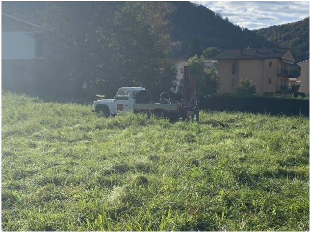
FOTOGRAFIA 10.Penetròmetre P-01. Emplaçament.
