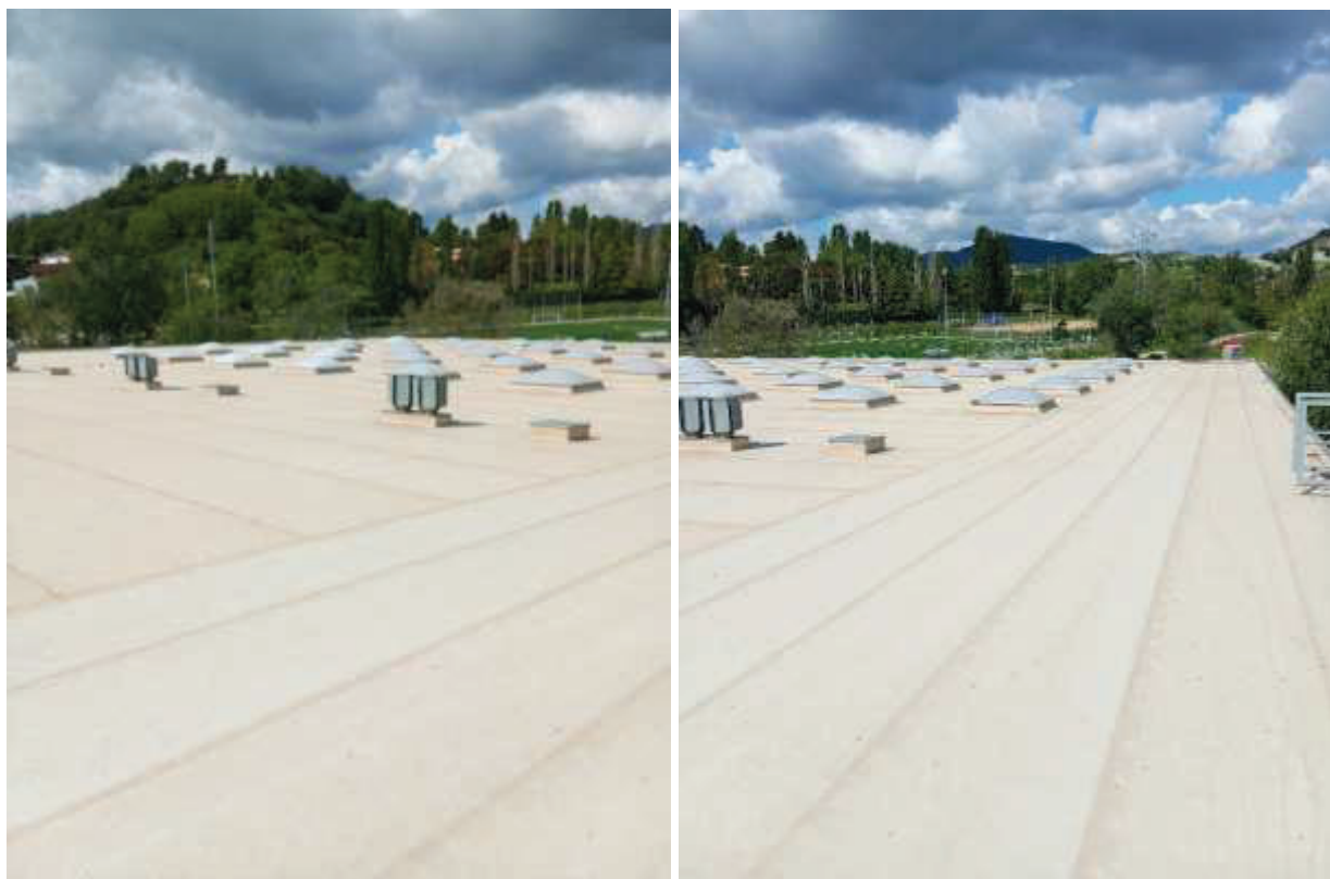
Imatge 3 i 4: Fotografies de la coberta on s'ubicarà el camp solar; Font pròpia
