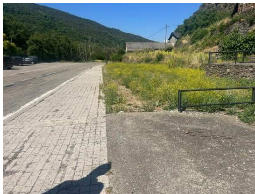
Imatges 02. Estat actual de la vorera límit Sud
