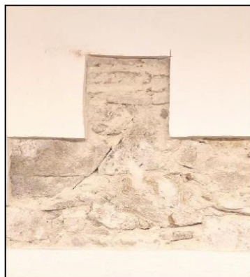
Cala a extrem est, ala sud-est
