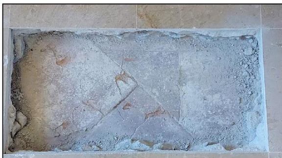
Cala realitzada al terra de la primera planta, sota el paviment actual s'observa el paviment de rajol original
