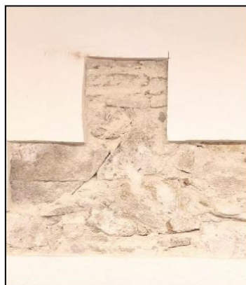
Cala a extrem est, ala sud-est
