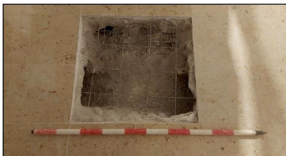
Cala realitzada sobre la sagristia, sota la malla metàl·lica s'observa la part superior de la volta
