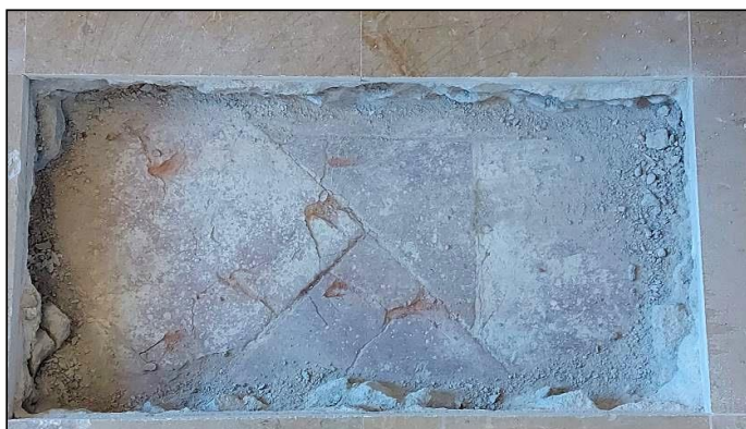
Cala realitzada al terra de la primera planta, sota el paviment actual s'observa el paviment de rajol original
