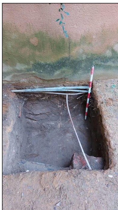
Cala realitzada a l'hort del rector, la fonamentació de façana s'assenta directament sobre la roca
