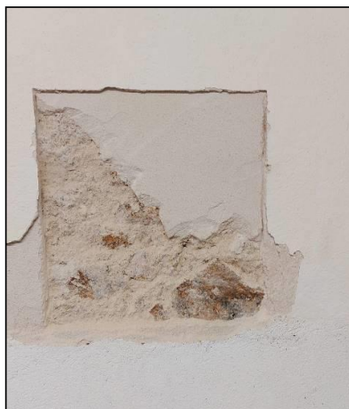
Cala on s'observa una primera capa d'arrebossat
