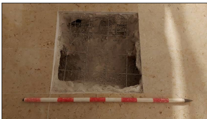
Cala realitzada sobre la sagristia, sota la malla metàl·lica s'observa la part superior de la volta
