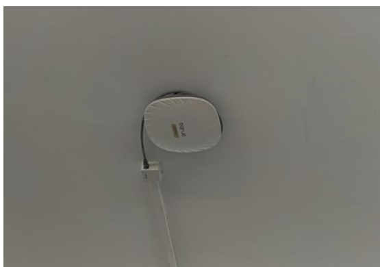
Fotografia nº6 –Punts d'accés Wifi , endoll sostre i enllumenat (Primaria).
