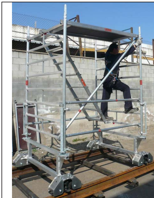
Montar la plataforma 1800 sin abertura (7) en la zona opuesta a la escalera 1800 con descansillo (10)
