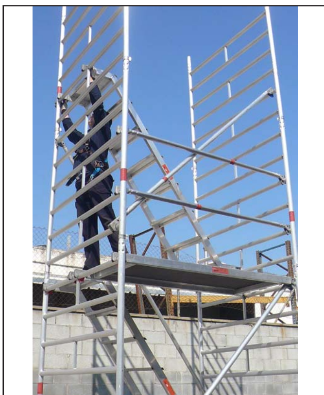
Montar la escalera 1800 con descansillo (10)
