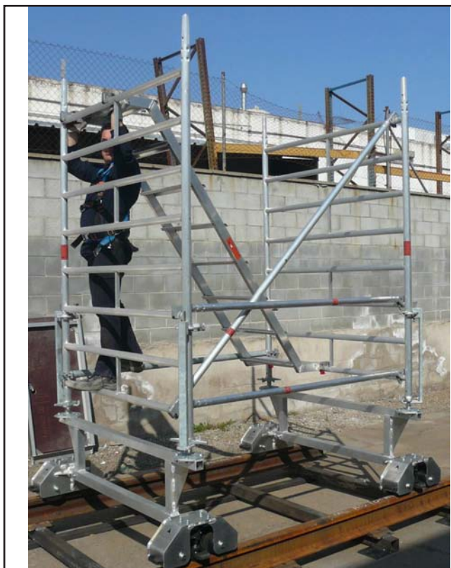
Montar la escalera 1800 con descansillo (10) y retirar la diagonal provisional instalada.
