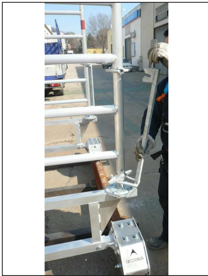
Asegurar la union mediante la pieza de union para base (17)
