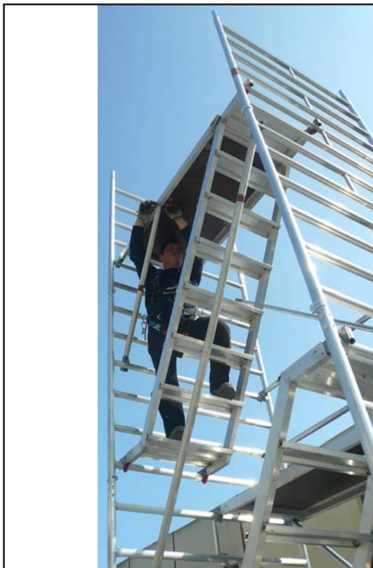
Las barandillas de escalera (11) se han de encajar en la parte inferior de la escalera 1800 (10)
