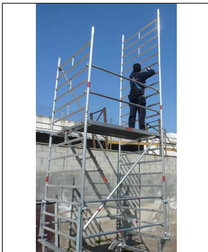
Montar el marco de aluminio 150/6 (4) en la parte opuesta a la superior de la escalera, asegurarlo con los clip (16)
