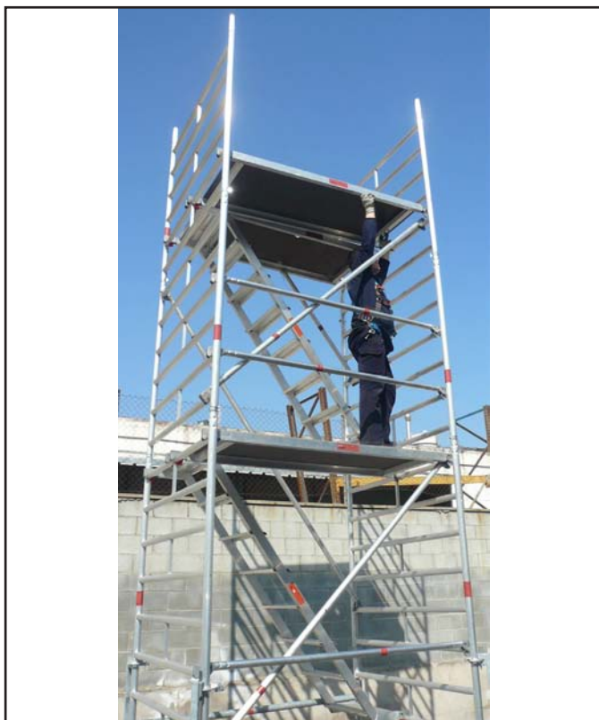
Montar la plataforma 1800 sin abertura (7) en la zona opuesta a la escalera 1800 (10)
