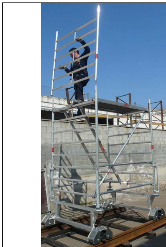
Montar el marco de aluminio 150/6 (4) en la parte superior de la escalera, asegurarlo con los clip (16)
