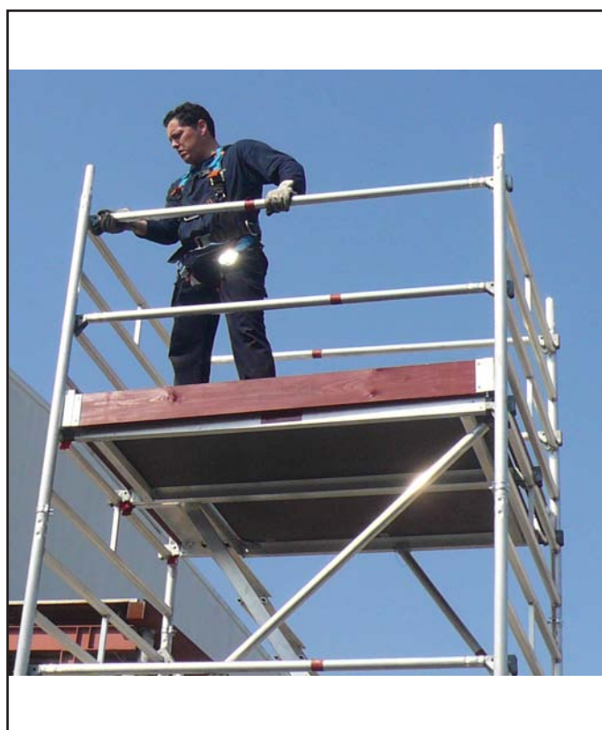
Unir los dos marcos de aluminio 150/8 (5) con dos barandillas 1800 (8)
