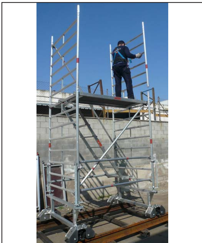
Montar el marco de aluminio 150/6 (4) en la parte opuesta a la superior de la escalera, asegurarla con los clip (16)
