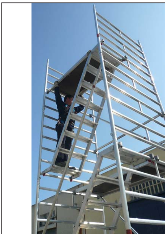
Montar la plataforma 1800 con abertura (6) en la zona de la escalera 1800 con descansillo (10)
