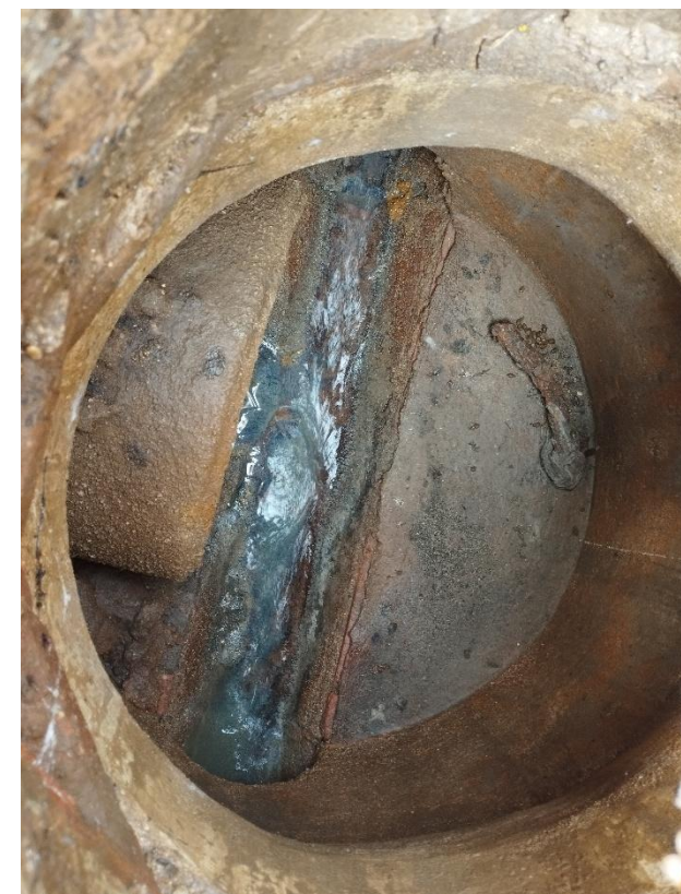
Fotografia 8. Interior de pou i connexió lateral
