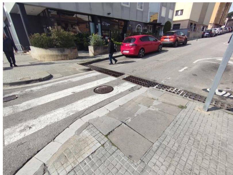
Fotografia 2. Pou inici de l'actuació (aigües avall)
