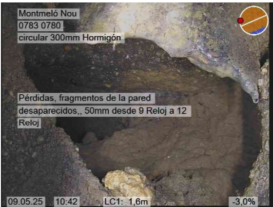
2, 00:00:20, 1.60m Pérdidas, fragmentos de la pared desaparecidos,, 50mm desde 9 Reloj a 12 Reloj
