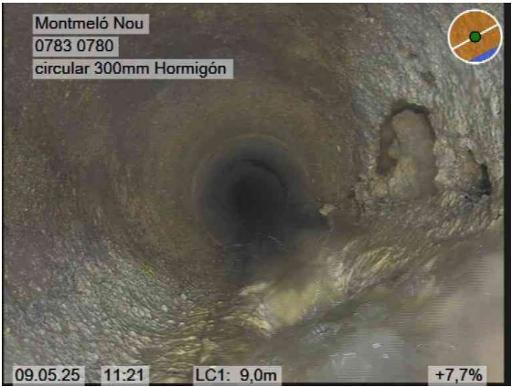
6, 00:05:03, 9.30m Pérdidas, fragmentos de la pared desaparecidos,, 20mm a 6 Reloj
