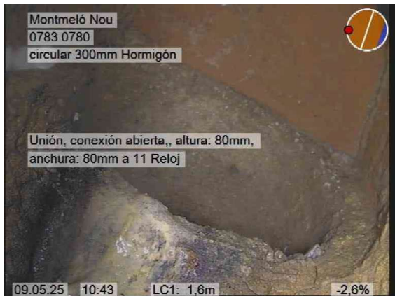
3, 00:00:32, 1.60m Unión, conexión abierta,, altura: 80mm, anchura: 80mm a 11 Reloj
