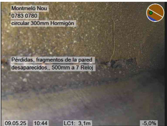
4, 00:00:55, 3.10m Pérdidas, fragmentos de la pared desaparecidos,, 500mm a 7 Reloj
