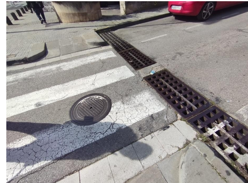
Fotografia 3. Detall pou inici de l'actuació
