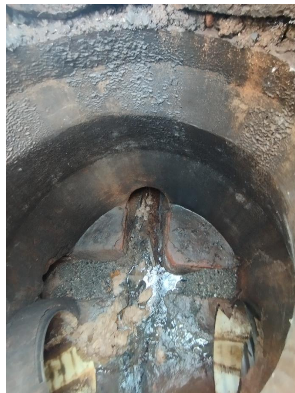
Fotografia 10. Interior de pou aigües amunt, carrer Balmes
