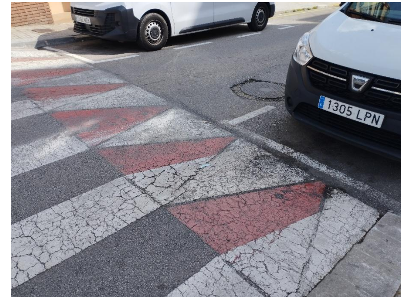
Fotografia 11. Detall remuntable i registre aigua potable
