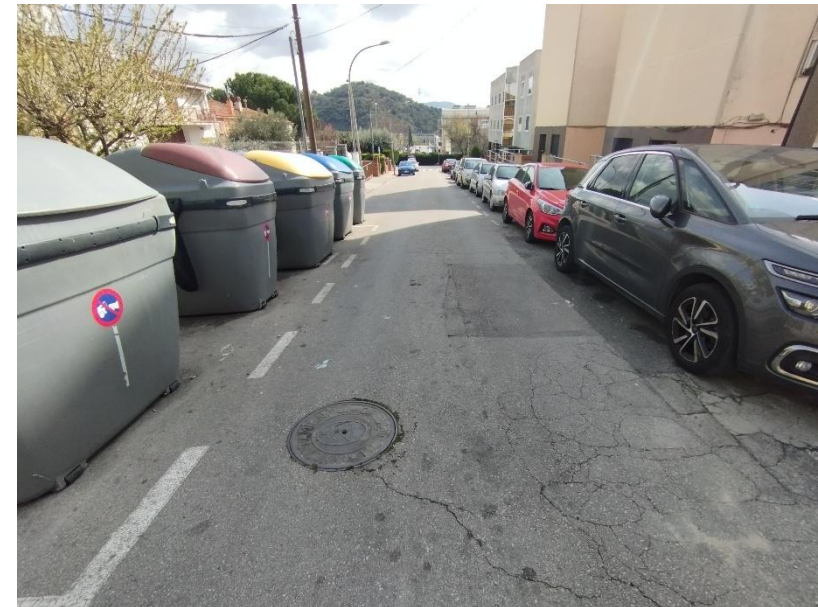
Fotografia 7. Pou intermedi, connexió canonada procedent de Passatge García Lorca
