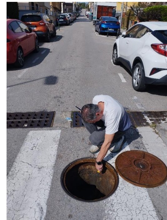
Fotografia 4. Treballs d'inspecció i presa de dades
