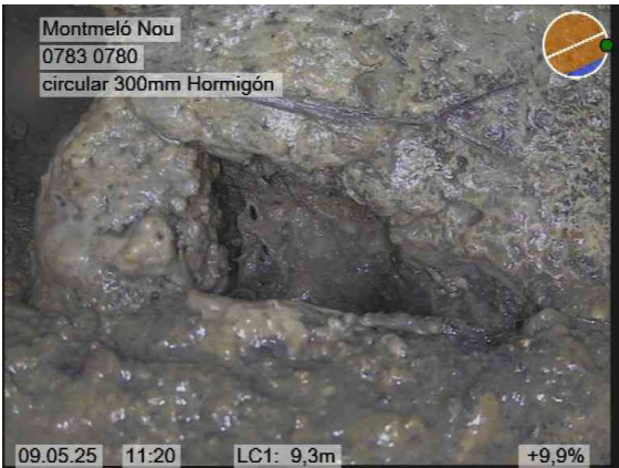
8, 00:05:19, 9.30m Pérdidas, fragmentos de la pared desaparecidos,, 500mm desde 3 Reloj a 6 Reloj
