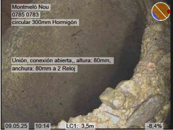
5, 00:01:00, 3.50m Uni3n, conexi3n abierta,, altura: 80mm, anchura: 80mm a 2 Reloj
