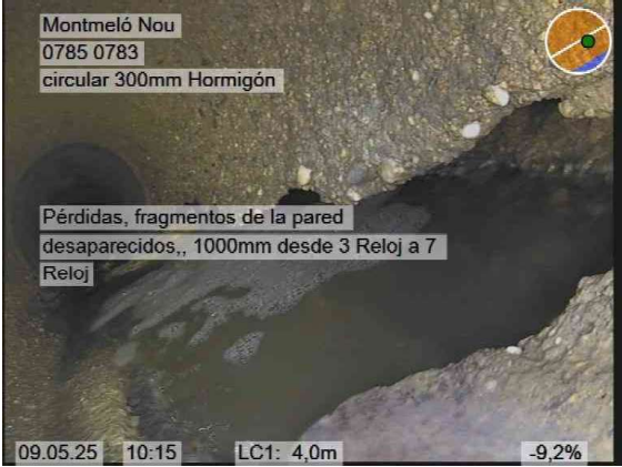
6, 00:01:16, 4.00m P3rdidas, fragmentos de la pared desaparecidos,, 1000mm desde 3 Reloj a 7 Reloj
