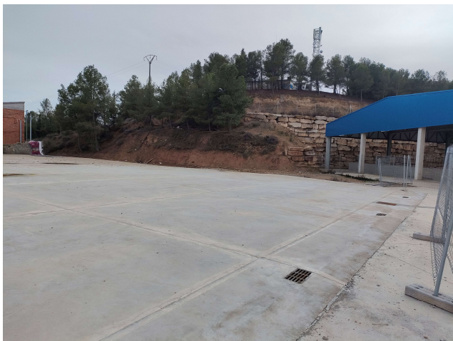
Vistes de la zona on ubicar la graderia
