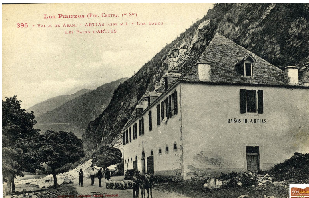
Banos d'Arties. [1900-1930]. Colleccion Frères Labouche - Archiu Generau d'Aran
