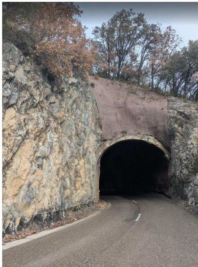
Fig.1. Túnel de Viu. Carretera N-260. Boca sud
