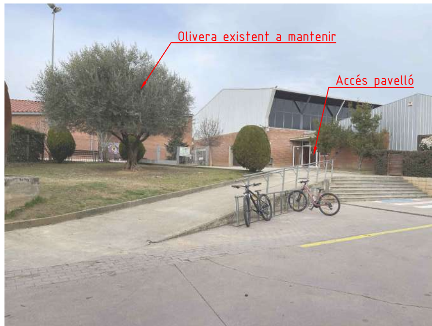
Rampa i escales actuals
