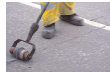
Figura 30. Imatge instal·lació d'obturator en el fons del tall.
