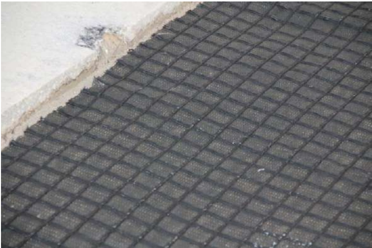
Figura 51. Imatge malla per reforç de paviment flexible.
