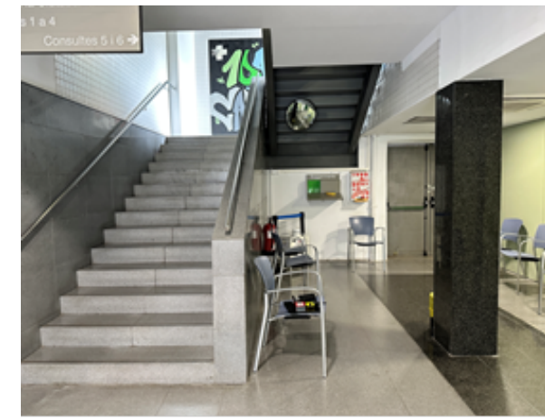
Cala: tancament interior, fonamentació i pilars
