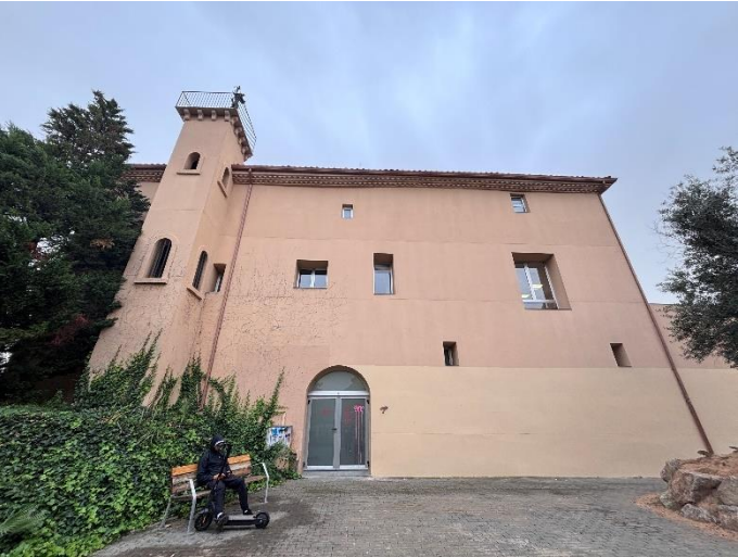
FACHADA NORTE, ACCESO SECUNDARIO AL EDIFICIO
