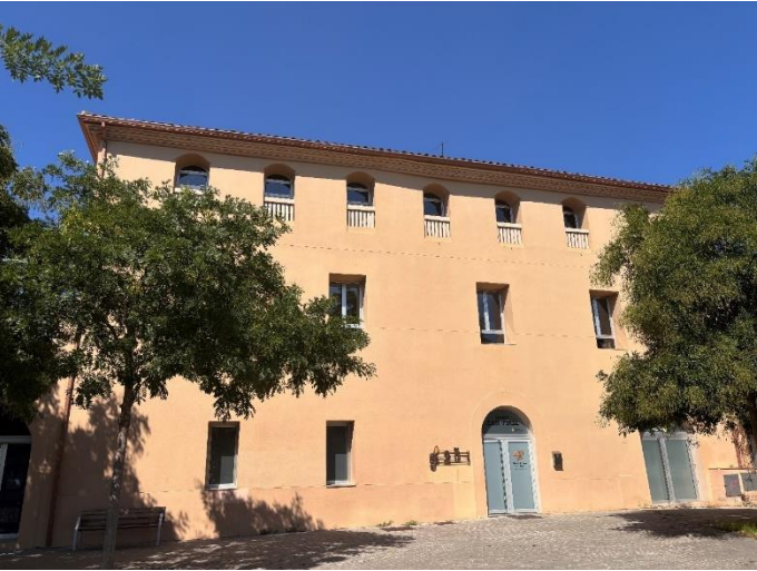
FACHADA SUR, ACCESO PRINCIPAL AL EDIFICIO
