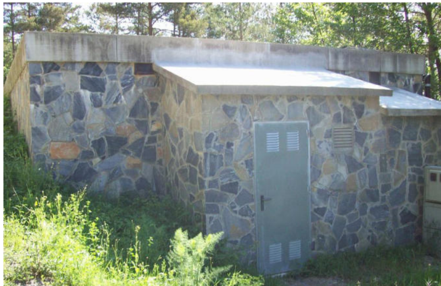
Figura 2. Dipòsit de Cal Tena
