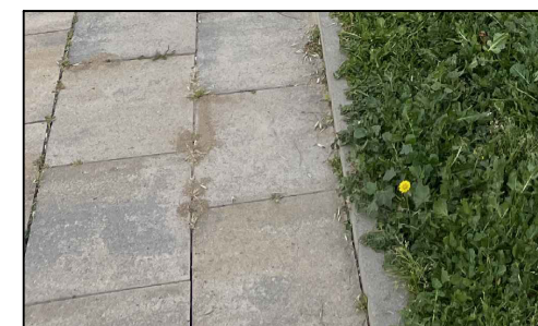
Paviment existent Imatge n°2
