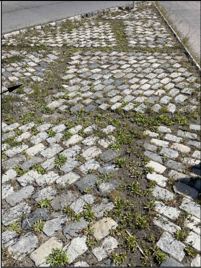
Preparació del terreny a les escletxes (C)
