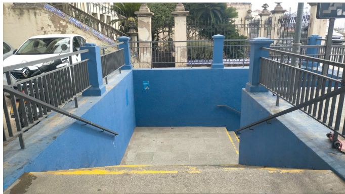
Fotografia 1. Vista general de l'accés muntanya del pas inferior
