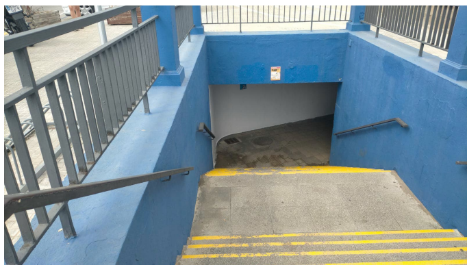
Fotografia 2. Vista general de l'accés mar del pas inferior
