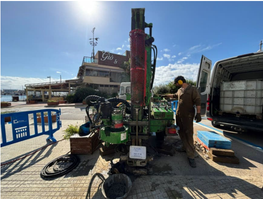
Fotografia 7. Assaig de penetració dinàmica DPSH PD1 (09/10/2024)
