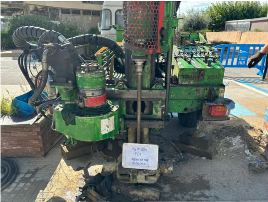
Fotografia 8. Assaig de penetració dinàmica DPSH PD1 (09/10/2024)
