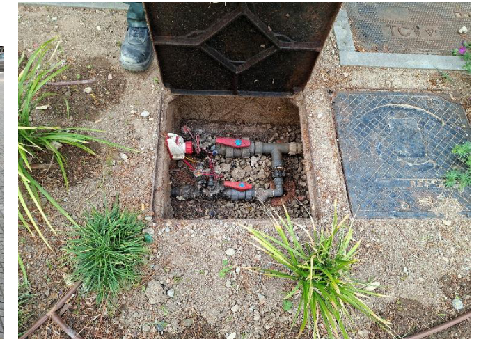
Electrovàlvules parterres D i F
