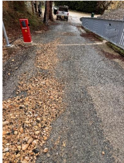
Foto 6. Vista general del estat del camí, en sentit descendent, cap a l'aparcament
