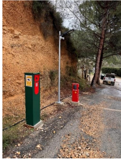
Foto 4. Vista general dels elements en sentit descendent, cap a l'aparcament
