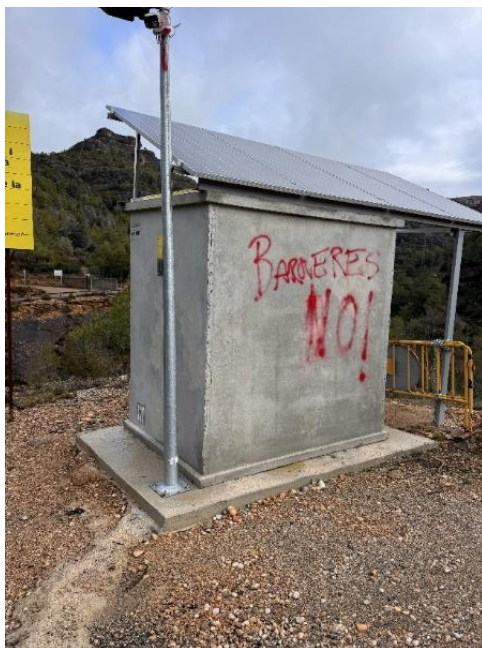
Foto 9. Vista general de la caseta existent
