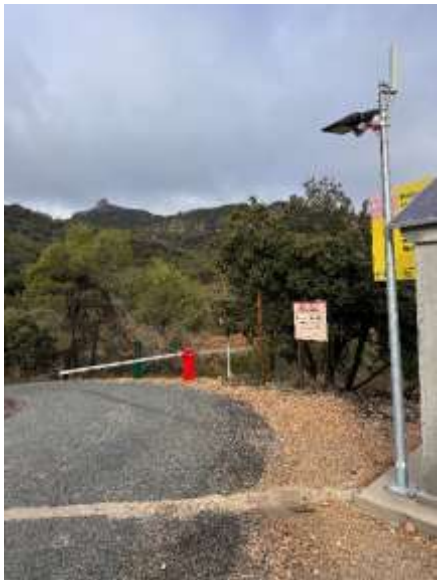
Bàcul existent al costat caseta tècnica
