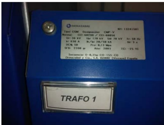
Imatge 4. Disposició d'elements MT a CT de PS1. Cel·les (5) i (6)
