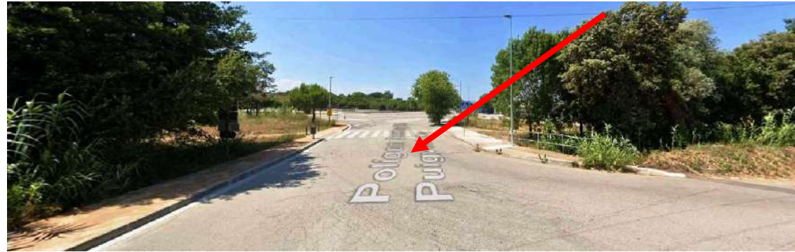
Fotografia 1. Vista general del pont de la Riera de Reixac a l'àmbit d'estudi
