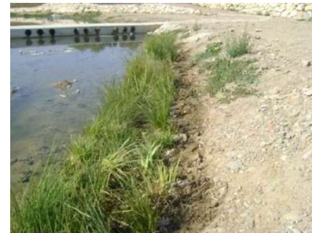
Exemple de plantació de macròfits a la zona de trobada dels talussos amb la llera
