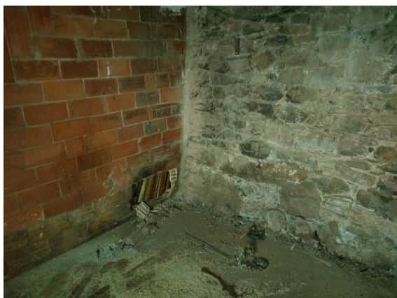
Imatges de l'espai on es preveuen instal·lar els dipòsits
