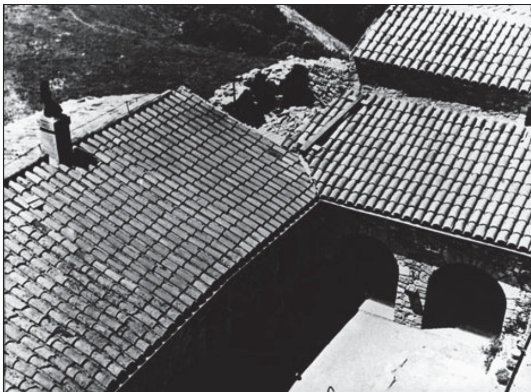
Vista des de la torre dels treballs de consolidació de coberta als edificis annexes. Anys 90' segle XX.
