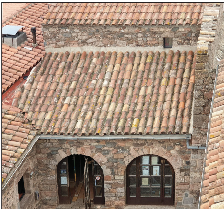
Vista des de la torre de la coberta de l'espai de recepció. Any 2022.
