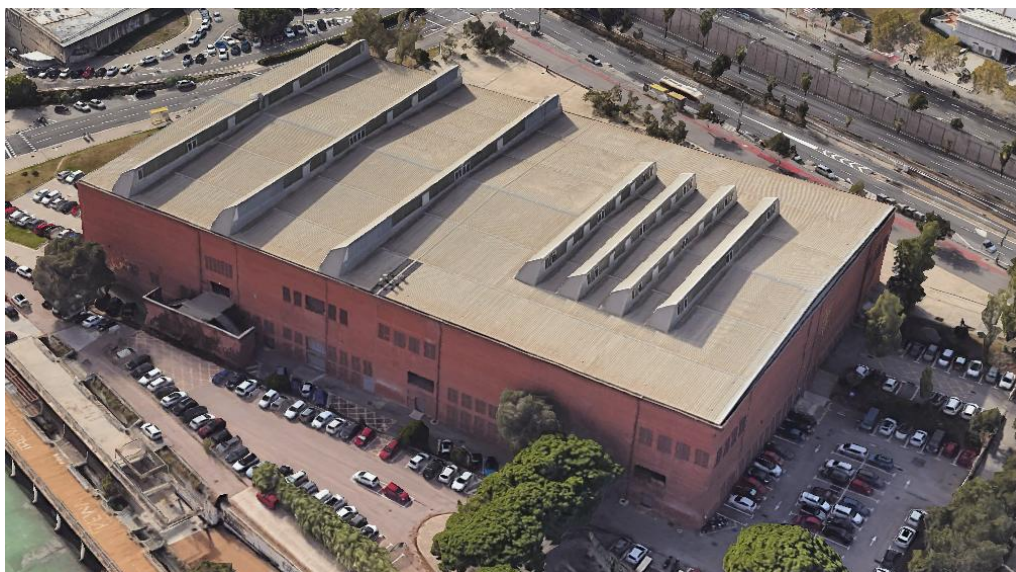
Fotografia 2.1 Vista general de la coberta de l'edifici del Centre Esportiu Municipal Ègora Olímpics.
