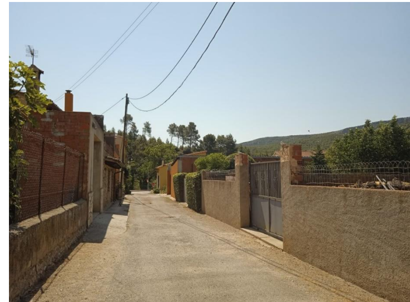
Figura 12. Estat actual Carrer del Pi.
