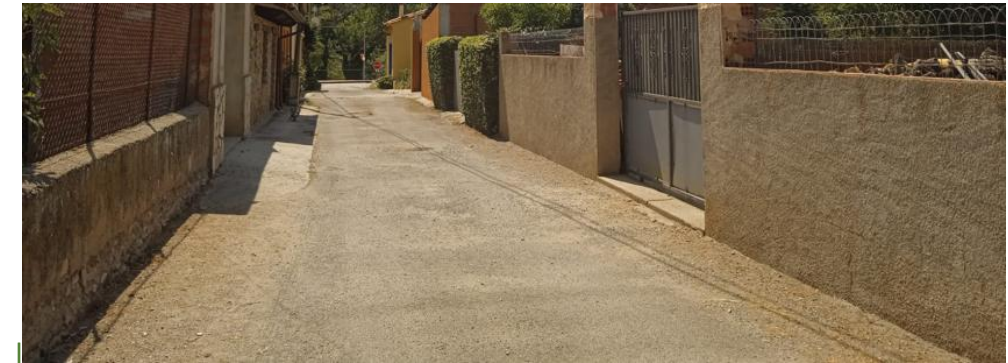
Figura 21. Pavimentació existent al Carrer del Pi.
