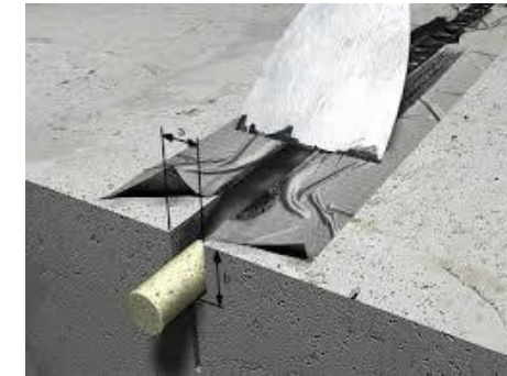
Figura 60. Imatge segellat de junta de dilatació amb cordó obturador en el fons del tall.
