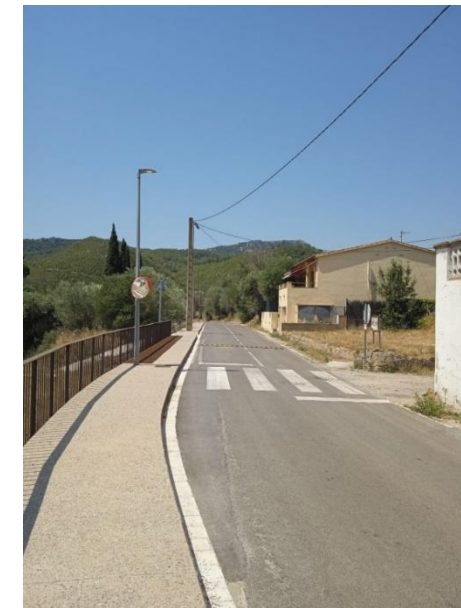
Figura 8. Fotografia estat actual connexió amb Carrer Nou.
