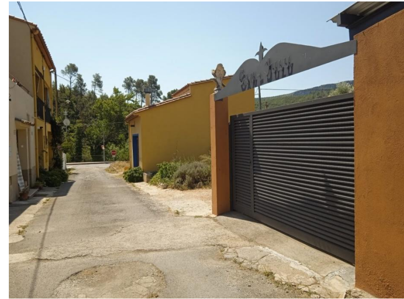
Figura 11. Estat actual Carrer del Pi.
