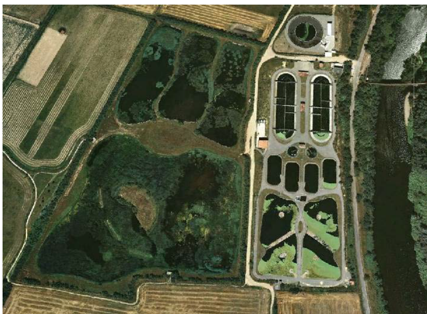
Figura 1. Ubicació del SAC i bombament Cortalet a l'interior del recinte de l'EDAR Castelló d'Empúries.
