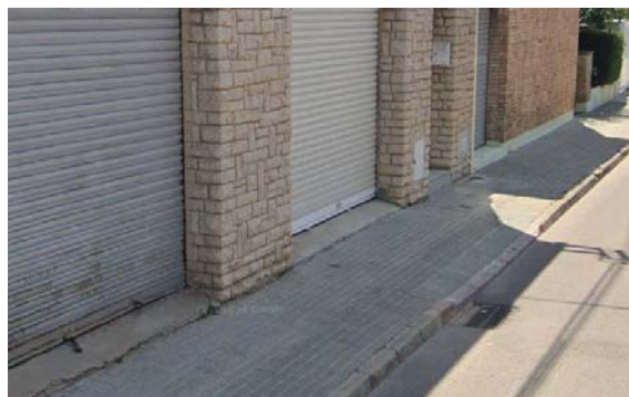
Figura 14. Tram D. Carrer de Tagamanent
