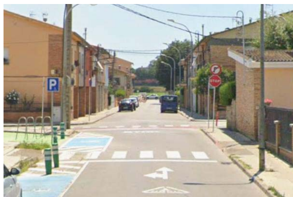
Figura 11. Tram D. Carrer de Tagamanent
