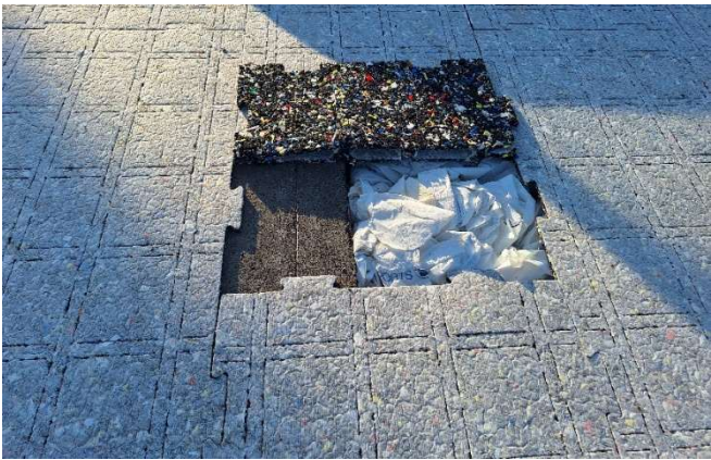
Desmuntatge i retirada de la base elàstica existent amb mitjans manuals. Base elàstica prefabricada de 20 mm gruix en peces encadellades de 2x1m aproximadament.
