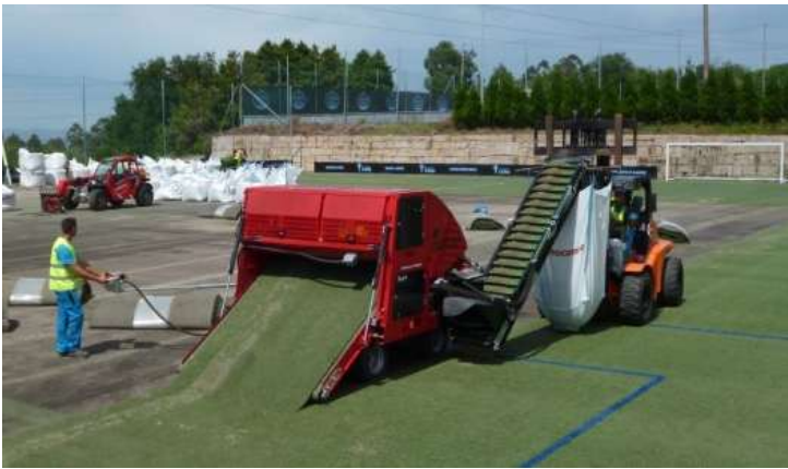
Desmuntatge i retirada de la base elàstica existent amb mitjans manuals. Base elàstica prefabricada de 20 mm gruix en peces encadellades de 2x1m aproximadament.
