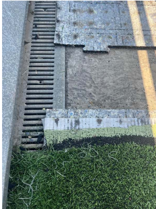
Cala d'estat actual de la impermeabilització
