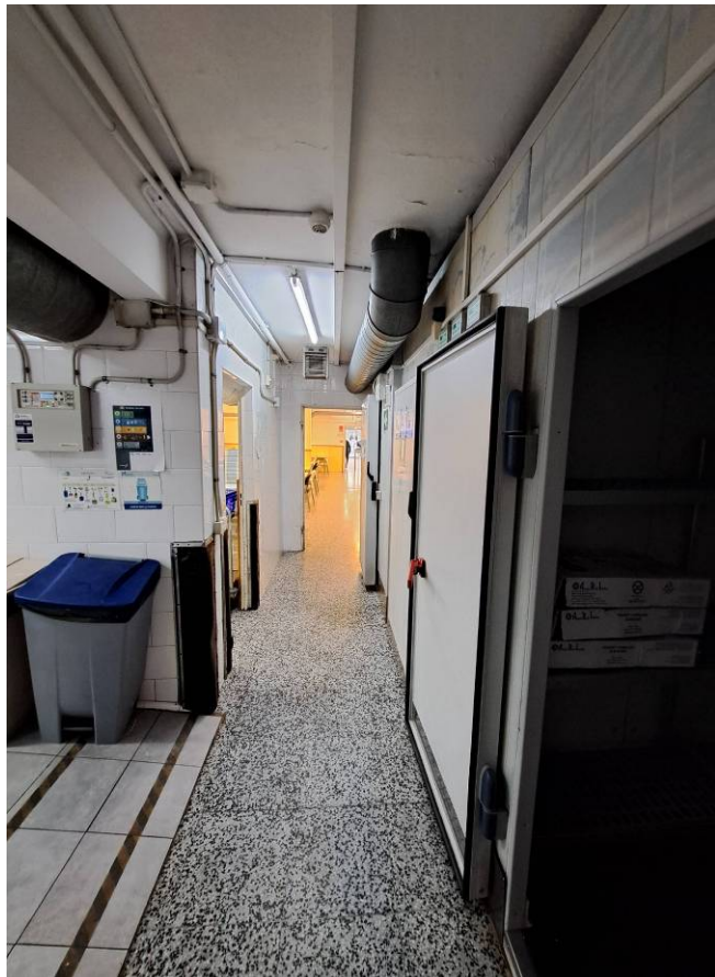
Vista del passadís amb les cambres frigorífiques
