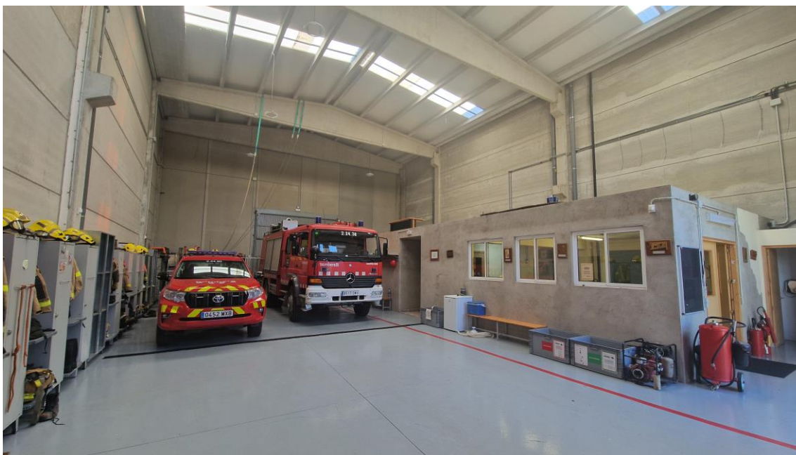
Imatge actual de la nau en qüestió on es pot visualitzar clarament l'estructura a base d'elements de formigó prefabricat.
