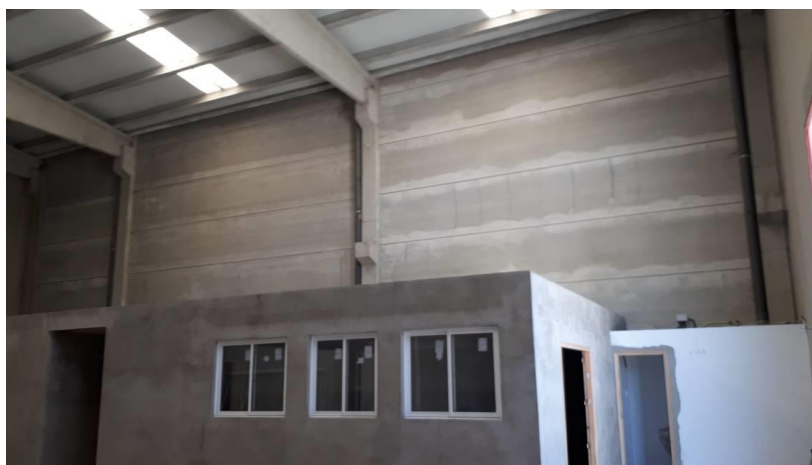
Imatge de l'interior de la nova nau en el moment en què s'estava adequant com a Parc de bombers.
