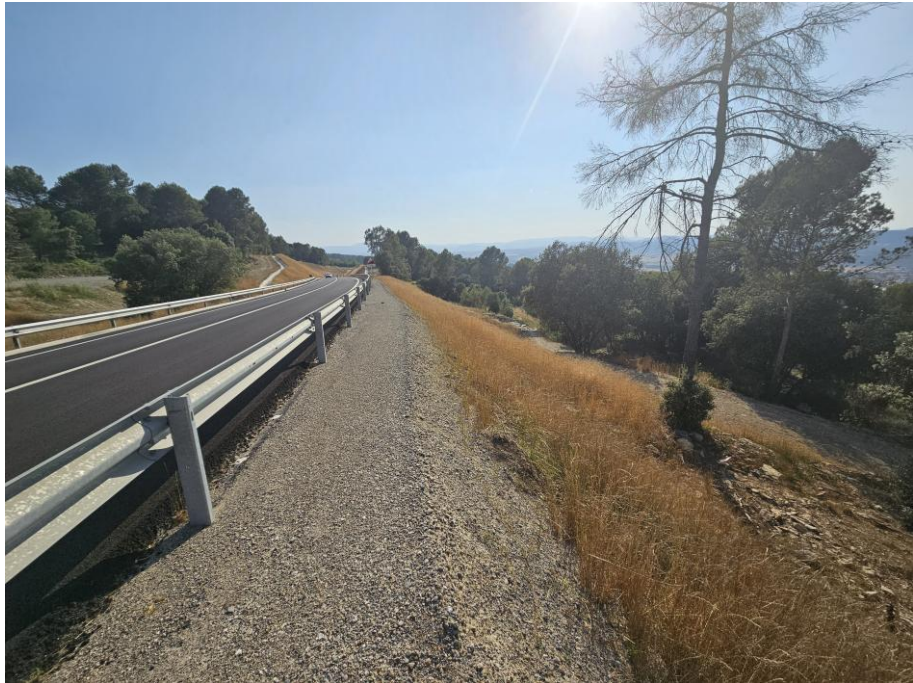
Imatge 6: Imatge representativa de talussos de terraplè de h>= 3 m (orientació obaga). Font: Imatge pròpia
