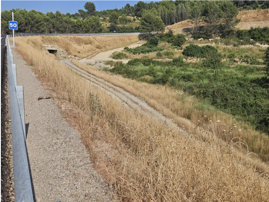
Imatge 5: Imatge representativa de talussos de terraplè de h>= 3 m (orientació solana). Font: Imatge pròpia
