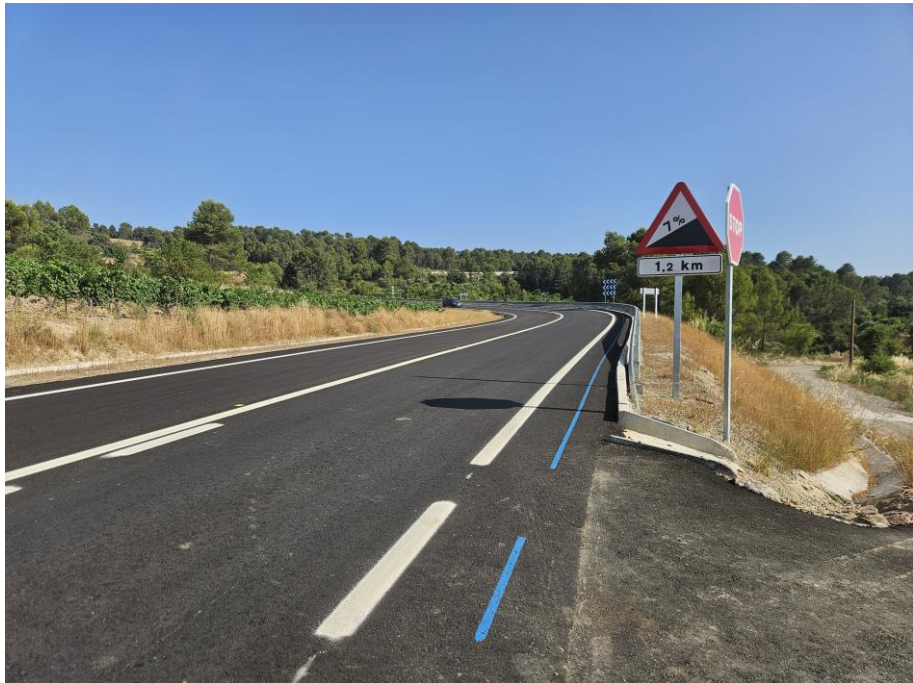
Imatge 4: Imatge representativa de talussos de terraplè de h<= 3 m. Font: Imatge pròpia
