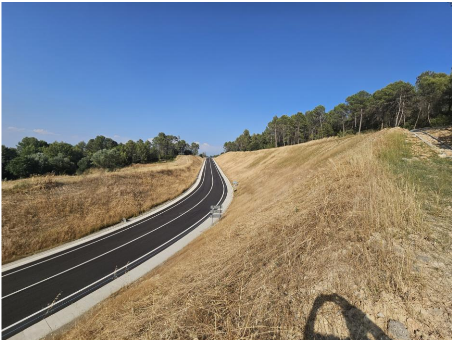
Imatge 3: Imatge representativa de talussos de desmunt, de h>= 3 m, amb diferent orientació (solana el talús esquerra i obaga el talús dret). Font: Imatge pròpia
