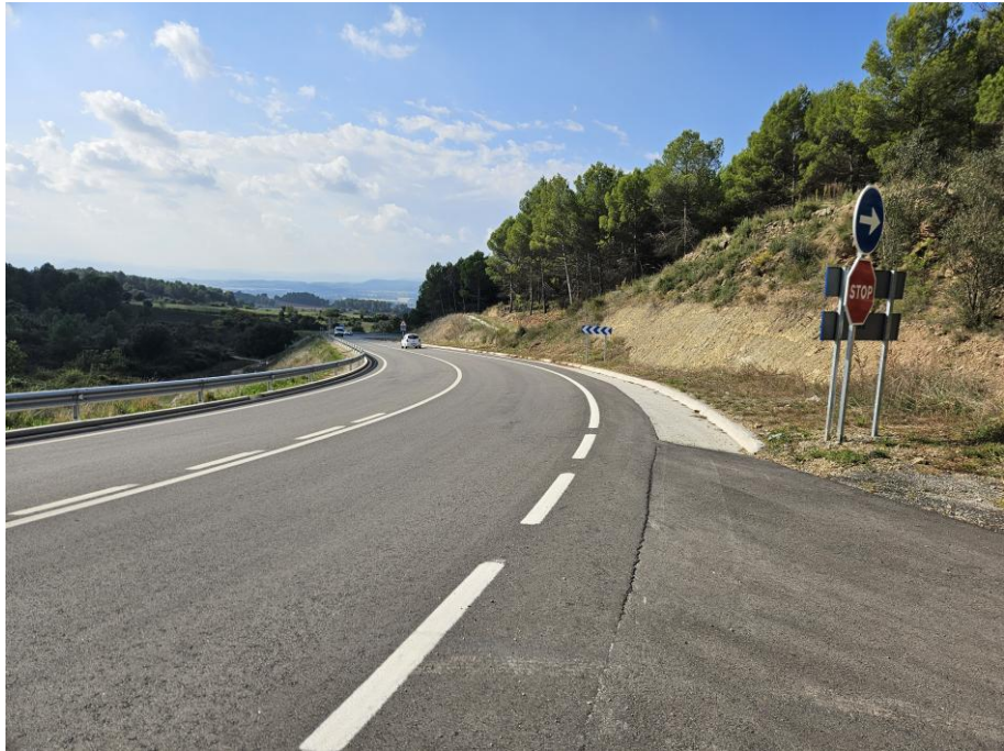
Imatge 9: Talús DS02 en primer terme i DS01 al fons ,on es preveu la col·locació de la manta de iute Font: Imatge pròpia
