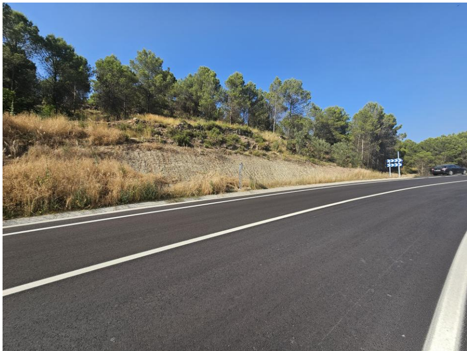
Imatge 2: Imatge representativa de talussos de desmunt, de h<= 3 m Font: Imatge pròpia
