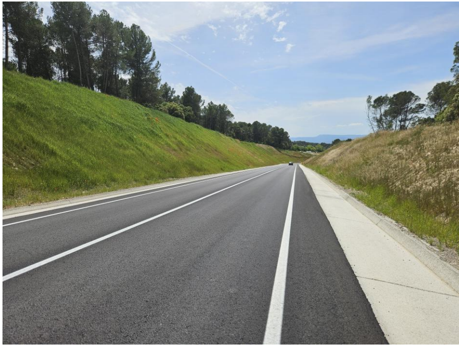
Imatge 10: Talús DS06 a la dreta i DO04 a l’esquerra, on es preveu la col·locació de la manta de iute Font: Imatge pròpia
