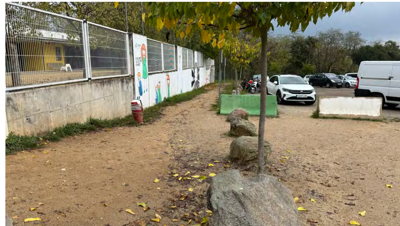
El lateral d'accés a l'Institut Vilamajor, està segregat de la zona d'aparcament mitjançant una rocalla i els vianants circulen sobre un paviment de sauló bastant irregular degut a que les aigües de pluja circulen per la seva superfície provocant arrossegaments al llarg del seu recorregut fins arribar a la Riera de Canyes.
