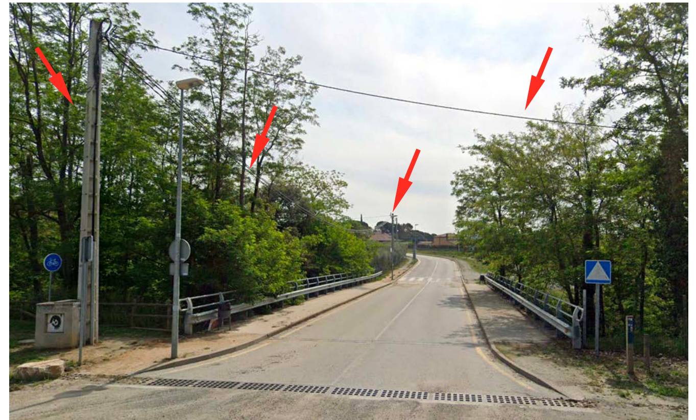
La fotografia mostra la línia elèctrica que discorre aèria per la vorera nord del pont i el pal de formigó on es converteix a soterrada. També es pot veure l'encreuament d'esquerra a dreta. D'altra banda ben a prop es mostra l'existència d'un bàcul d'enllumenat públic.
