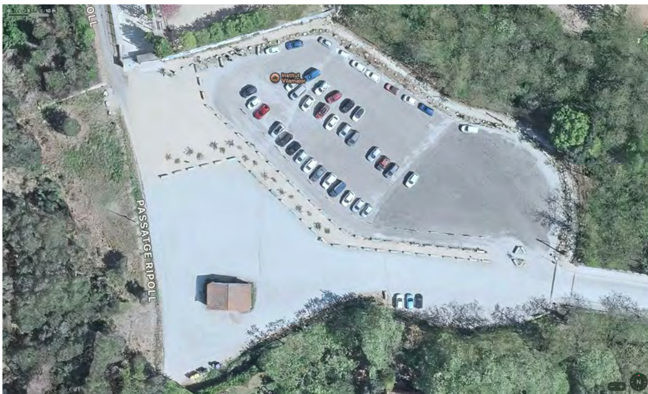
Ortofoto de la zona d'actuació. La superfície de la zona d'actuació és d'uns 8.116 m 2 aproximadament.
