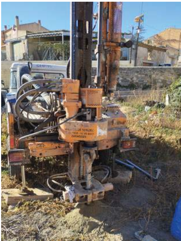
Vistes dels quatre sondeigs realitzats a la parcel·la objecte d'estudi, P-1 i P-2 del tipus DPSH i, S-3 i S-4 del tipus Rotació helicoidal.
