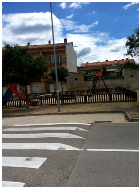
Fotografia 1: Embornal afectat a prop d'un parc infantil. C. Teula
