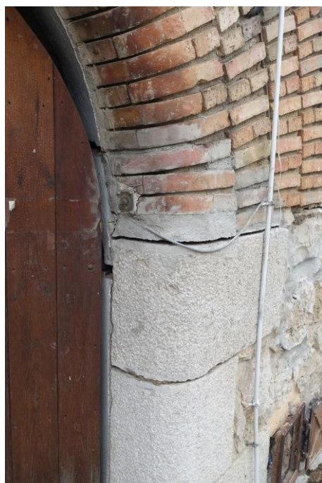
Detall de la fàbrica de l'arc de mig punt
