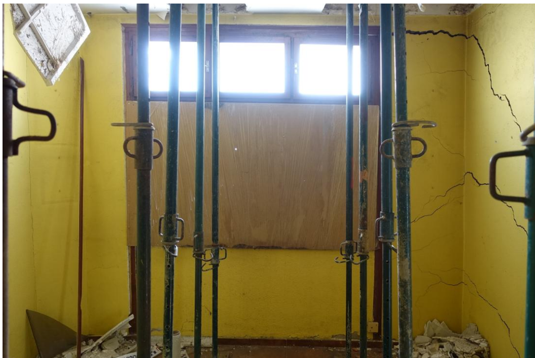
Imatge des de l'interior en direcció a la façana principal
