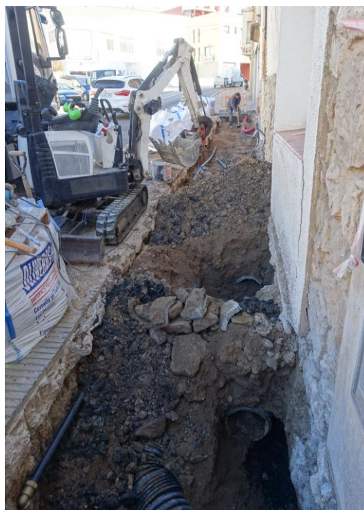
Excavació per dames per a l'omplert dels pous amb formigó
