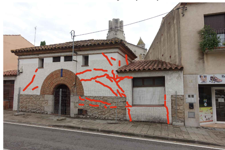
Direcció de trencament de la façana principal
