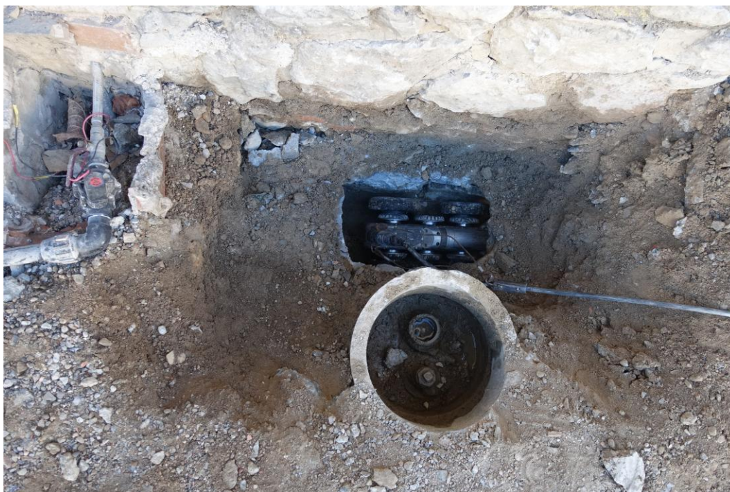
Inspecció de l'estat de conservació del conducte adossat a la façana principal
