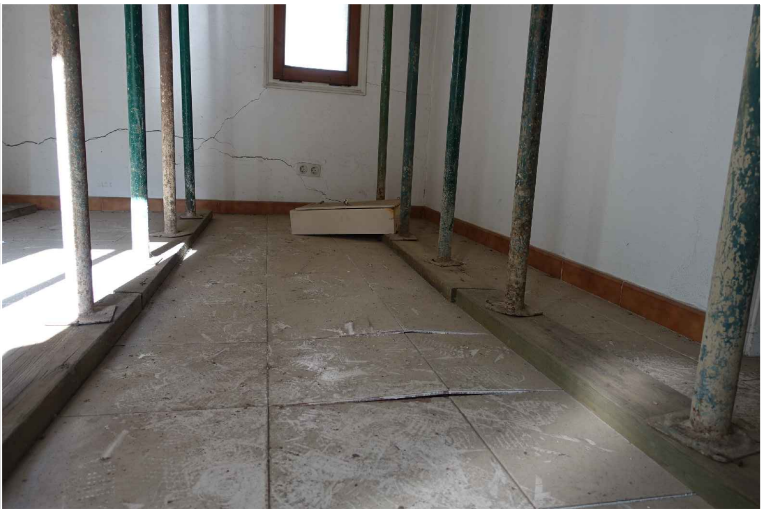
Trencament del paviment de la cel·la d'homes
