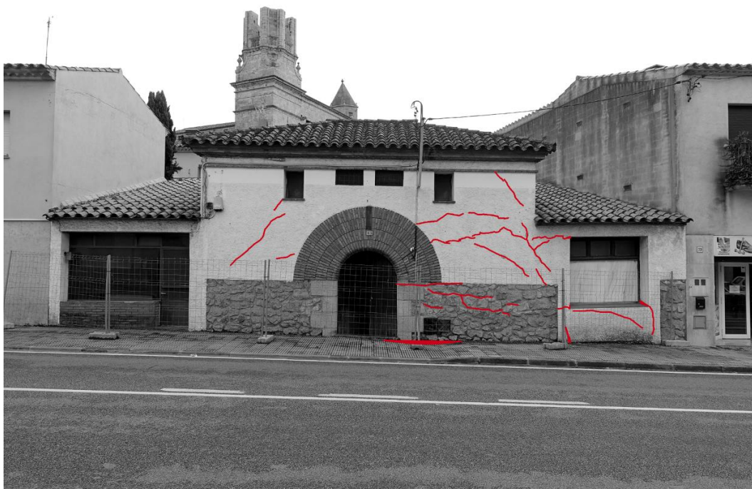
Esquema de trencament de la façana principal
