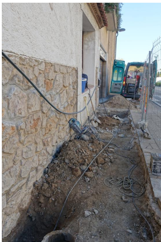
Imatge del procés de la inspecció exterior
