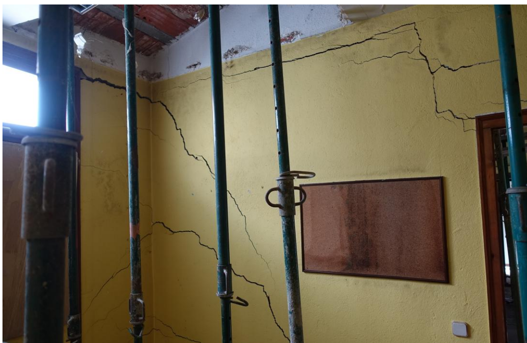
Imatge del tancament lateral dret en direcció a la façana principal
