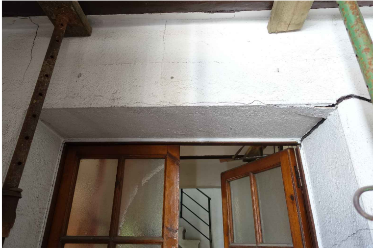
Formació d'esquerdes i fissures en sostres i paraments
