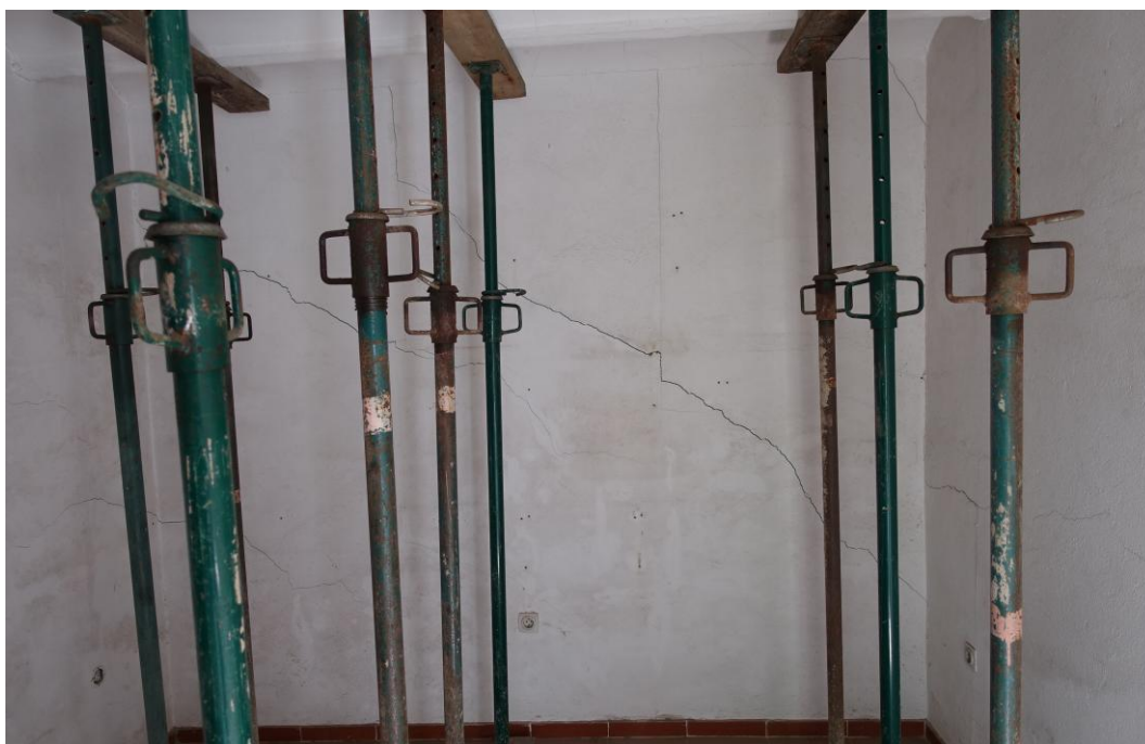
Imatge del tancament corresponent a la façana principal
