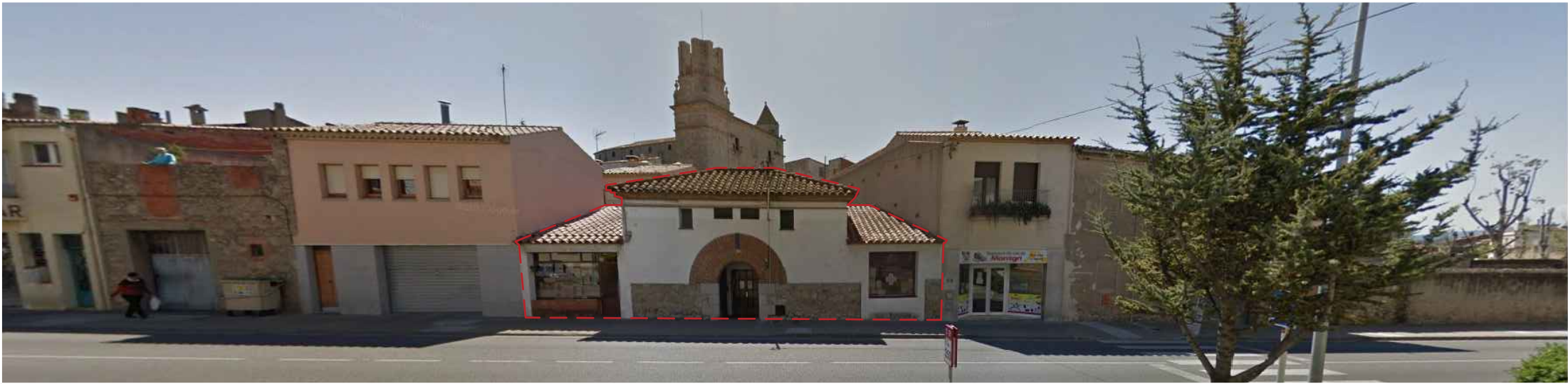
IM 01 - Imatge general de la façana principal situada a l'avinguda de Lluís Companys
