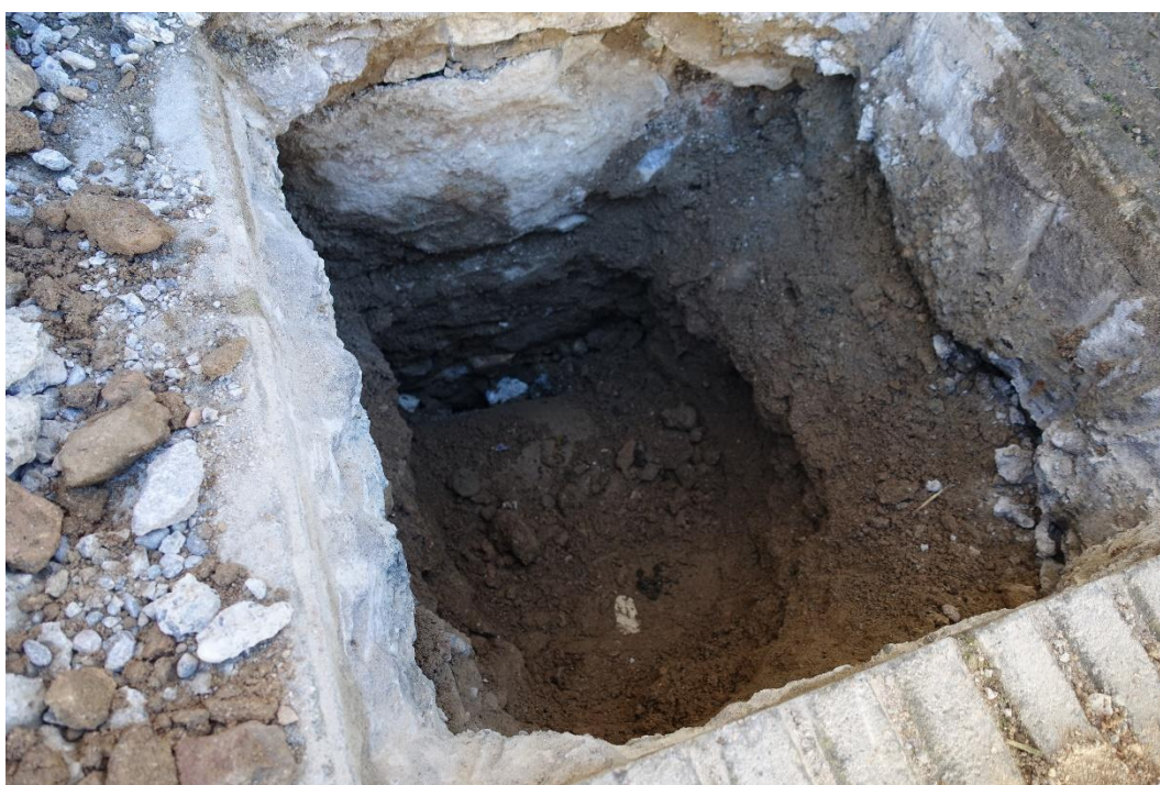
P2 – Imatge del procés de prospecció de la vessant est de la façana principal
