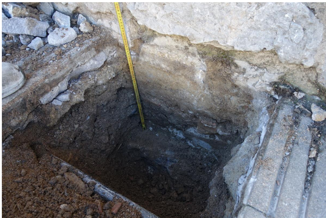
P1 – Imatge del procés de prospecció de la vessant oest de la façana principal i medició
