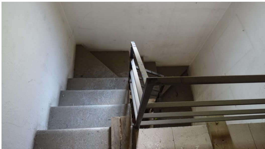
Imatge de l'escala des del distribuïdor de la planta primera
