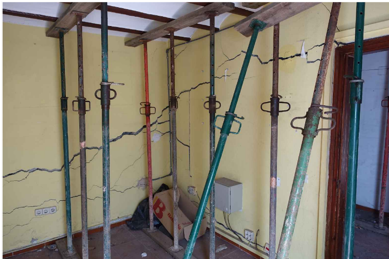
Imatge del trencament entre els murs de façana i perpendicular Trencament del mur perpendicular a la façana principal
