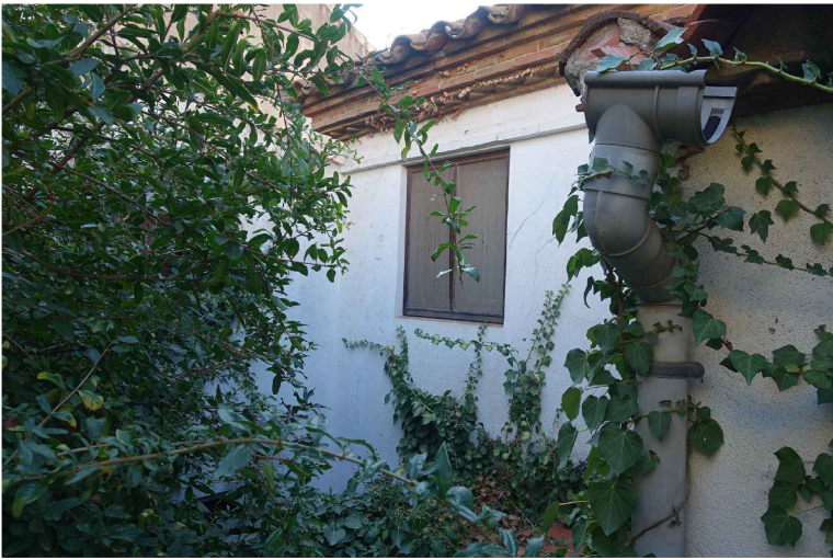
IM 04 - Imatge parcial de la façana posterior
