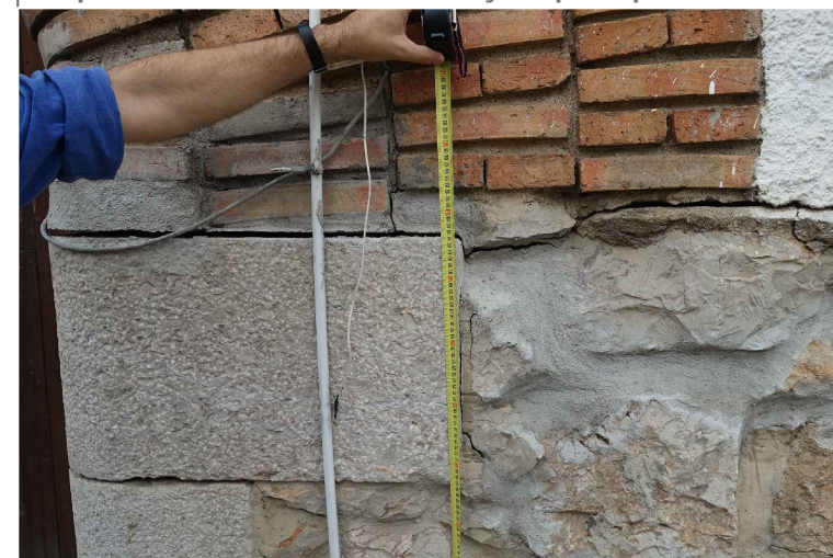
Desplom de 7cm al centre de la façana principal
