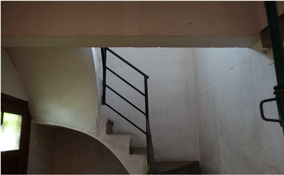
Estat de conservació de l'escala interior.
