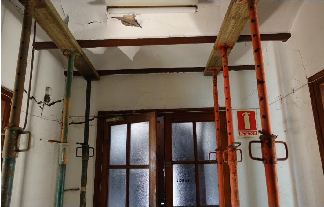
Imatge des del vestíbul en direcció a l'entrada des de l'interior de l'edifici
