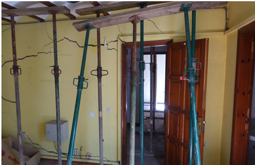
Imatge del tancament dret de l'espai en direcció a la façana principal
