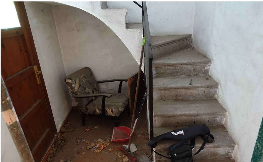
Estat de conservació de l'escala interior.
