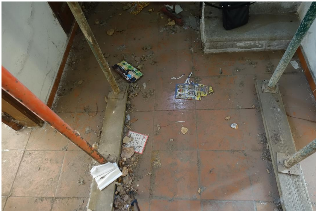
Imatge del paviment del vestíbul en el tram corresponent a l'inici de l'escala
