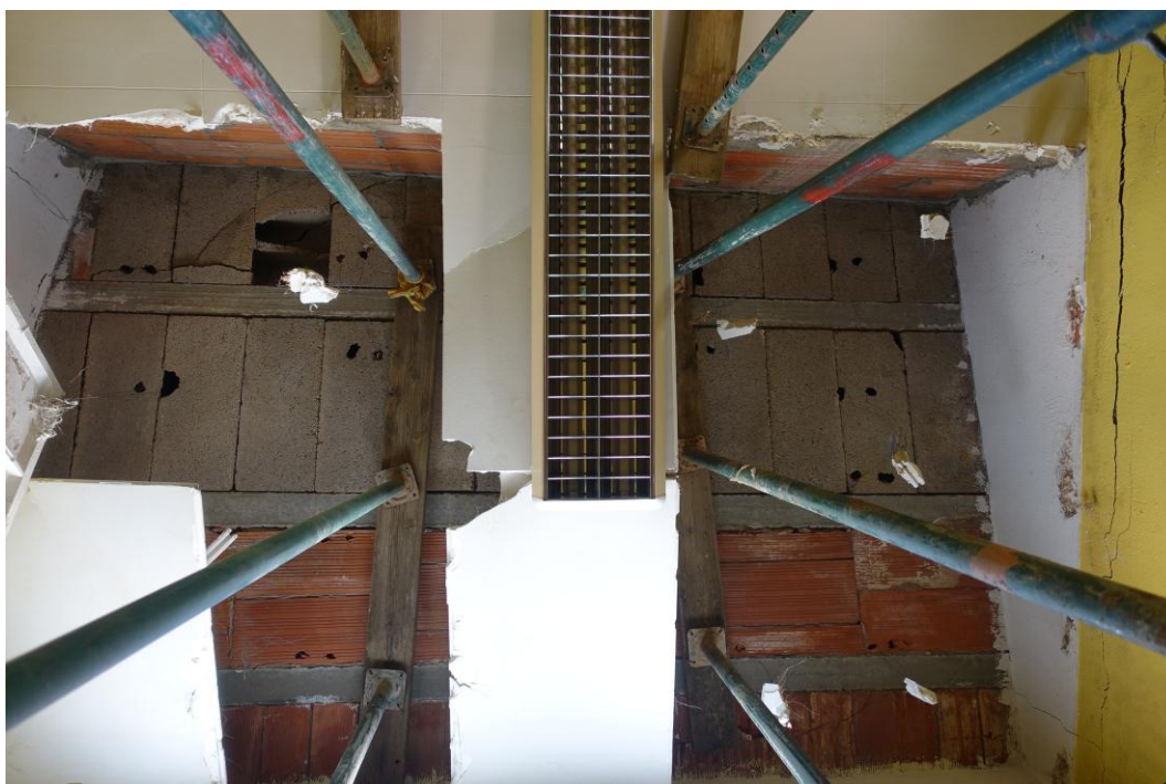
Detall del sostre proper a la façana principal de l'edifici
