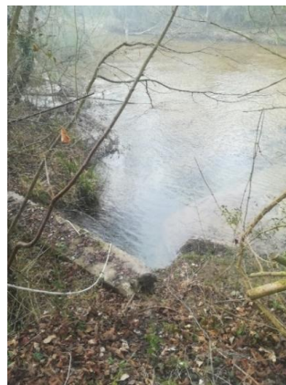
Figura 5. Captació de Fornès
