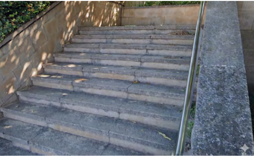
REPOSICIÓ PAVIMENT ESCALA PUJADA DE LES PEDRERES
