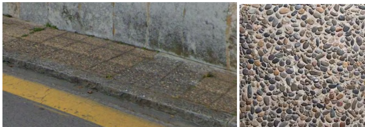
Figura 24. Paviment de vorera existent carrer Regiment de Baza.
