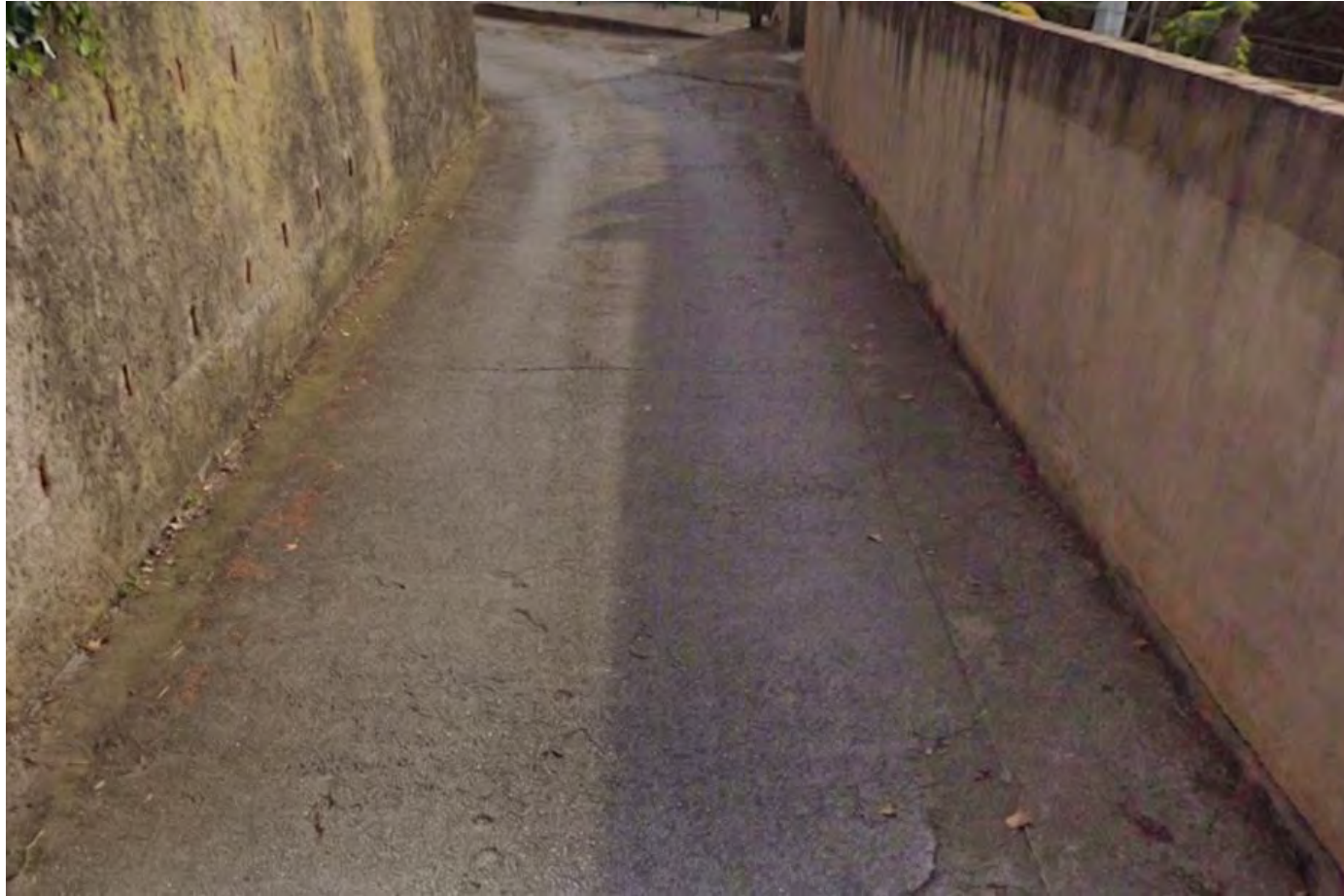
Figura 23. Paviment formigó calçada carrer dels Caputxins.
