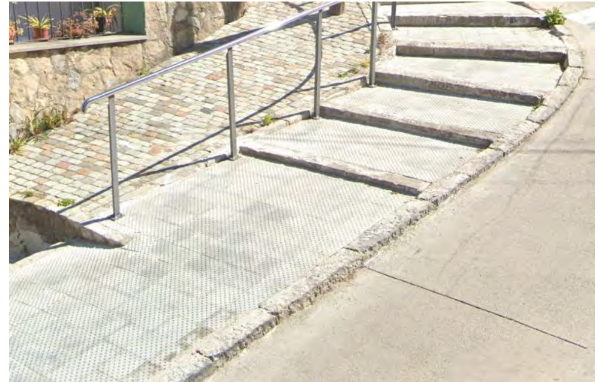
Figura 25. Paviment existent carrer Pujada de les Pedreres.
