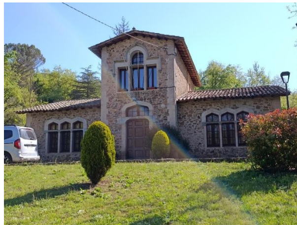
Fotografia de la façana
