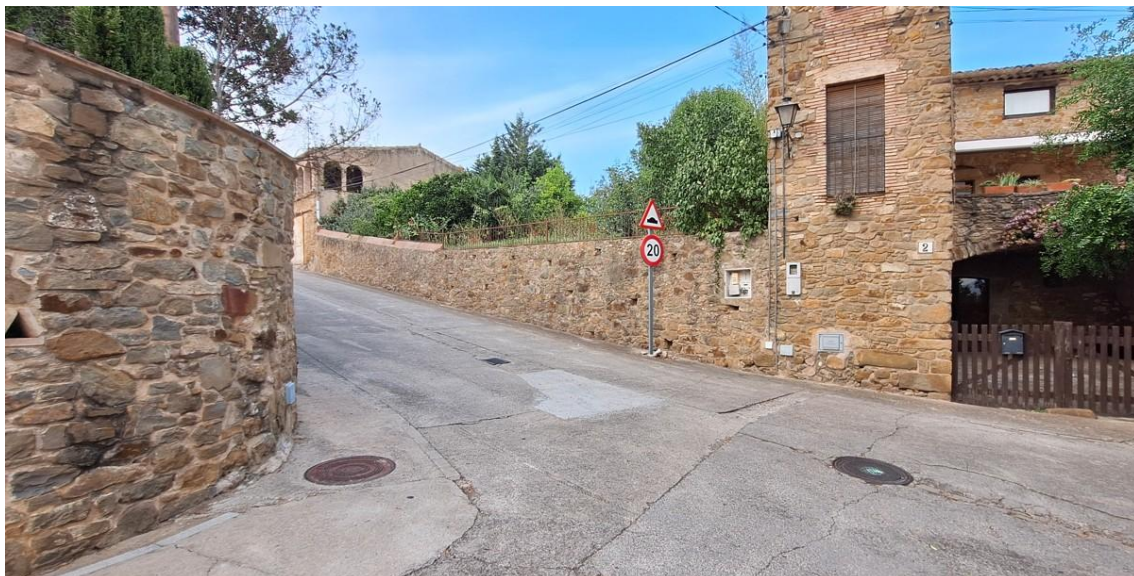
Fotografia 1_ Carrer Nou, vista cap a nord, a l'inici del carrer davant número 4.
