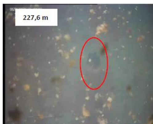
Càmera lateral. Mostra corrosió circular
