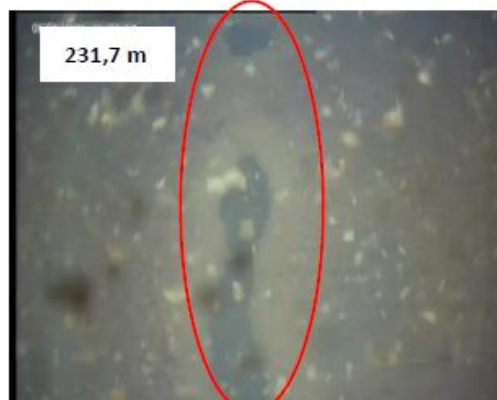
Càmera lateral. Mostra corrosió lineal
