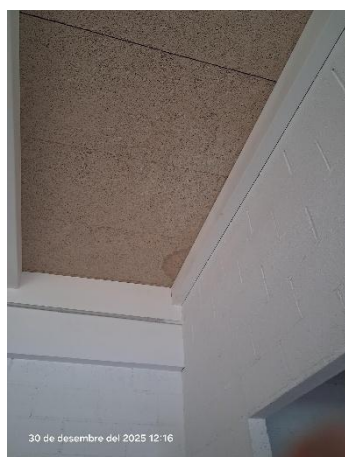
Fotografia 23 – Vista sostre cuina
