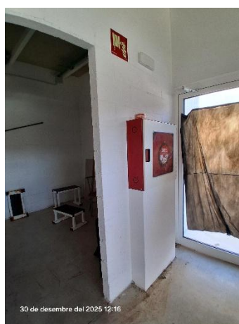
Fotografia 04 – Vista des de sala-menjador cap magatzem
