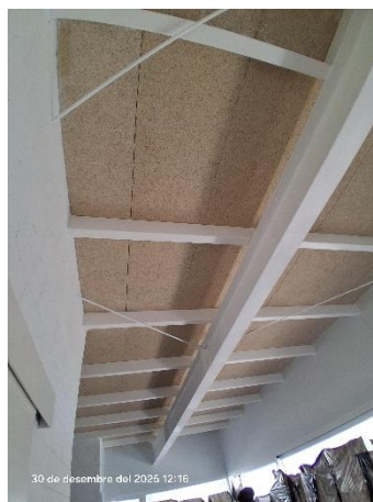
Fotografia 10 – Vista sostre sala-menjador
